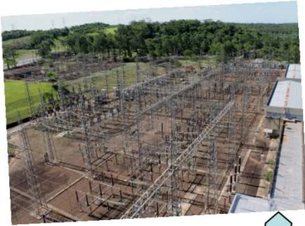
**\*PATIO DE MANIOBRAS 220 KV;** CON CAPACIDAD TOTAL DE TRANSMISION DE 780 MVA. A TRAVEZ DE TRES LINEAS DE SALIDA DE 200 MVA A CNEL.OVIEDO Y UNA DE 180 MVA A C.A.LOPEZ, AL SUR. COTA 165:00. AQUÍ LLEGAN 2 LINEAS DE TRANSMISION DE LA BINACIONAL ITAIPU. EL 70% DE LA ENERGIA CONSUMIDA EN EL PAIS PASA POR LA CENTRAL ACARAY.
