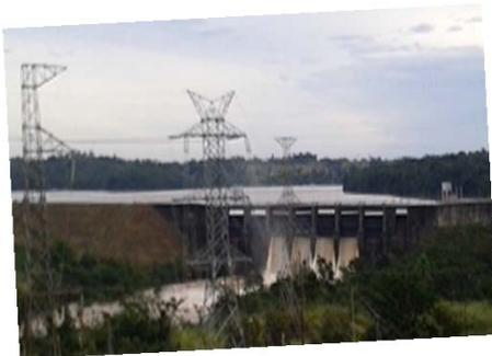
**\*EMBALSE PRESA ACARAY ;** LA COTA DE EMBALSE VARIA ENTRE 178:50 METROS COMO MINIMO Y 185:00 METROS COMO MAXIMO DE ALTURA S.N.M.
