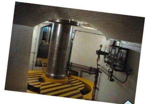
**\*EJE TURBINA FRANCIS ;** ESTA FORJADA EN UNA SOLA PIEZA CON LAS BRIDAS DE ACOPLE INTEGRALMANTE. ES PERFORADO UN AGUJERO DE 250mm. DE DIAMETRO A TRAVEZ DEL EJE PARA LA INSPECCION DEL MATERIAL. SITUADA EN CASA DE MAQUINAS DE ACARAY I. COTA 90:40
