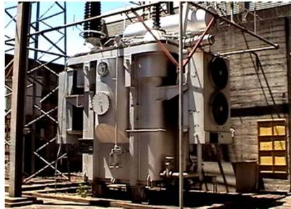
**\*TRAFO ELEVADOR DE TENSION ;** DE 13,8 A 220 kV (COTA 133:00), SALE DEL GRUPO GENERADOR Y TRANSMITE AL PATIO, 220 kV, DE MANIOBRAS. COTA 165:00
