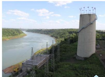
**\*CHIMENEA DE EQUILIBRIO:** DE ACARAY II CON UNA ALTURA TOTAL DE 39 m. Y UN DIAMETRO INTERIOR DE 15 m. ESTA PROTEGE LAS INSTALACIONES DE LOS EFECTOS DE SOBREPRESION ORIGINADOS POR LAS VARIACIONES DE VELOCIDAD DE AGUA.
