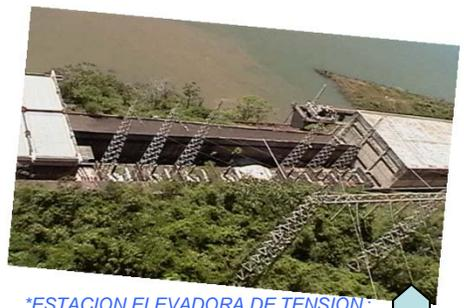
**\*ESTACION ELEVADORA DE TENSION;** DONDE SE ENCUENTRAN LOS TRAFOS DE 13,8/220 kV, UBICADOS EN COTA 133:00 , CASA DE MAQUINAS DE ACY I y ACY II , SOBRE EL MARGEN DERECHO DEL RIO PARANA.
