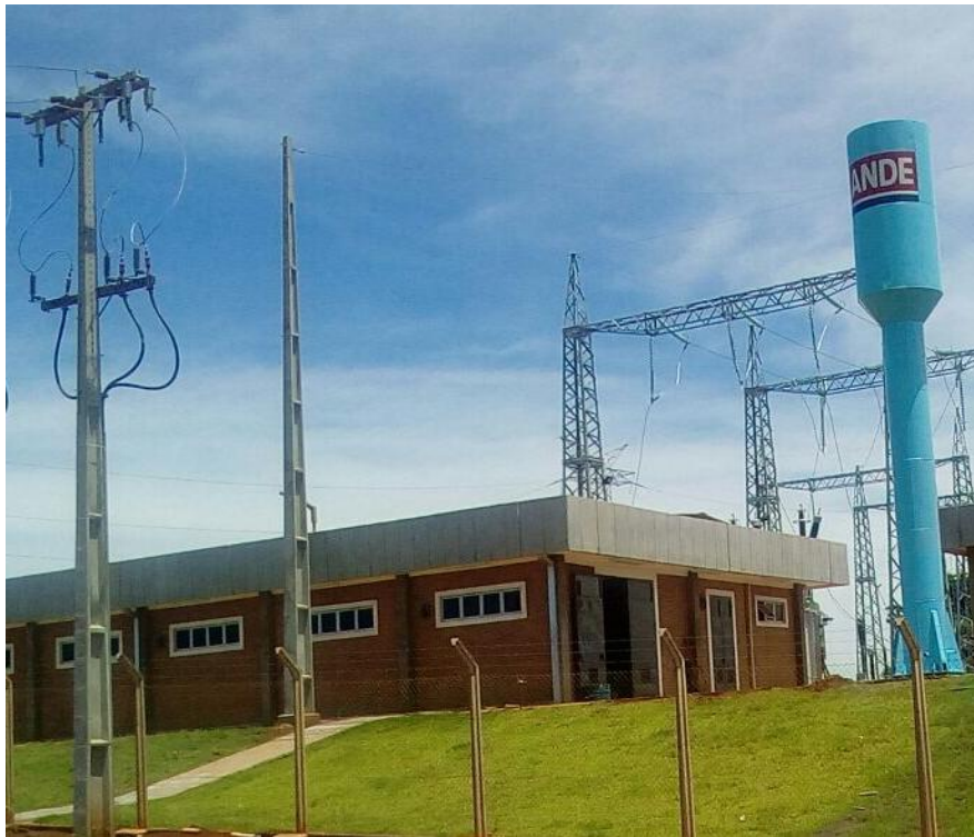
Construcción de la Subestación CAPITÁN BADO 220/23 KV - Licitación Pública Nacional ANDE N° 851/2013 - Lote 4 - BONOS I
