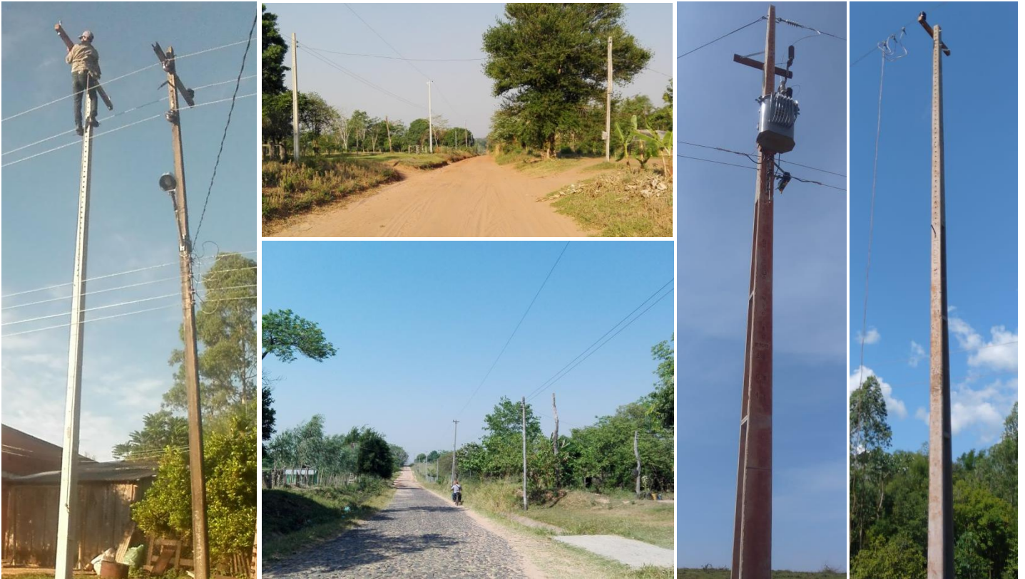
Ejecución de Trabajos de Normalización de Líneas de Autoayuda en MT y BT Canindeyú y San Pedro - Licitación Pública Nacional ANDE N° 1016/2014 - Lotes 1, 2, 3 - BONOS I
