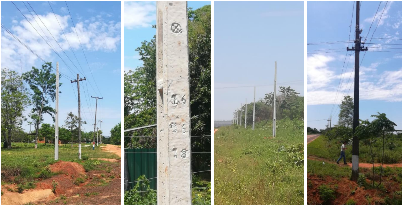
Construcción de Redes de MT, BT y Montaje de PD. Licitación Pública Nacional ANDE N° 1321/2017, Asent. Tava Guaraní, Distrito de Santa Rosa del Aguaray. Dpto. de San Pedro. Lote 2 – Bonos II
