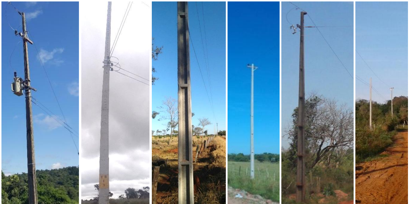
Ejecución de trabajos de normalización de 376 km de líneas de autoayuda en MT y BT, en el Dpto. de Cordillera - Licitación Pública Nacional ANDE N° 1170/2015 – Lotes 1, 2, 3, 4, 5 v 6 - BONOS II
