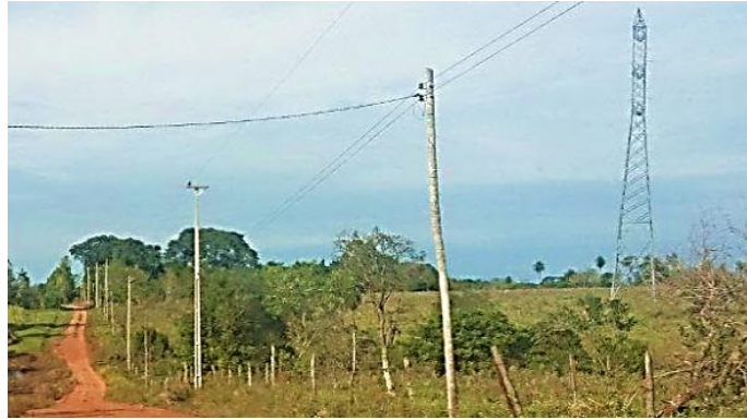
Ejecución de Trabajos de Normalización de Líneas de Autoayuda de BT y MT Licitación Pública Nacional ANDE N° 991/2014 - Lotes 3 y 6 - BONOS I
