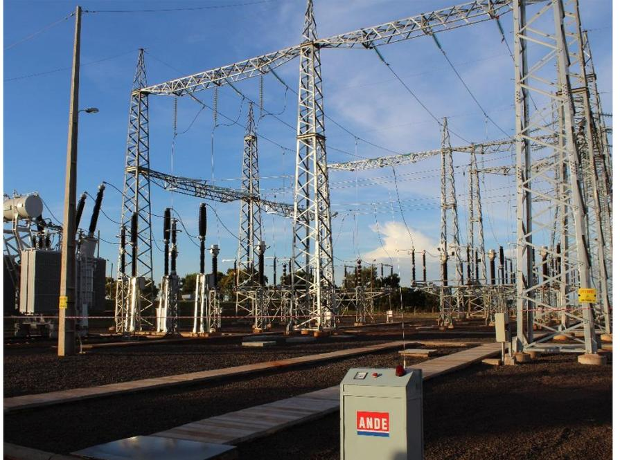
Construcción de la Subestación CERRO CORÁ 220/66/23 kV
