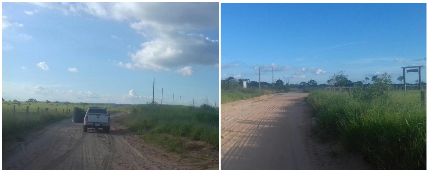
Adecuación de Línea de Media Tensión y Baja Tensión, y Montaje de Puesto de Distribución para Asentamientos de los Distritos de Curuguaty, Ybypyta, Villa Ygatymi, Corpus Cristi (Lote 1). Licitación Pública Nacional ANDE N° 1172/2015
