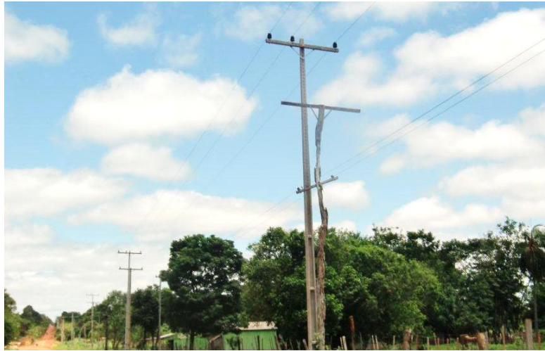
Ejecución de Trabajos de Normalización de Líneas de Autoayuda en MT y BT Canindeyú, Maracaná - Licitación Pública Nacional ANDE N° 969/2014 - BONOS I
