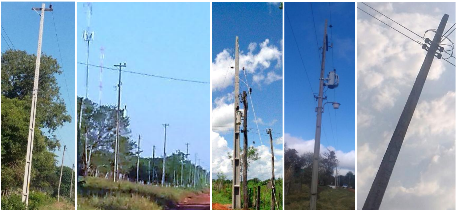
Ejecución de Trabajos de Normalización de Líneas de Autoayuda en MT y BT Licitación Pública Nacional ANDE N° 992/2014 - Lotes 1. 2. 3. 4 y 5 - BONOS I
