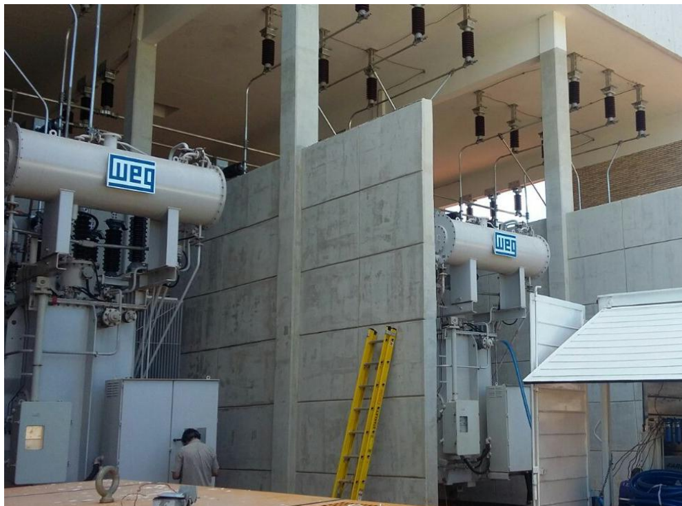
Construcción de la LT 66 kV subterránea SAN LORENZO - FDO. DE LA MORA - Licitación Pública Nacional ANDE N° 852/2013 - Lote 2 - BONOS I
