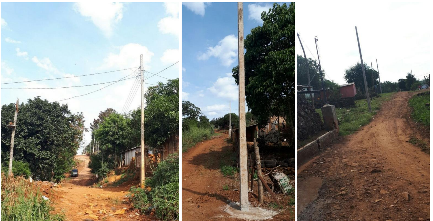
Construcción de Redes de MT, BT y Montaje de PD. Licitación por Concurso de Ofertas N° 956/2017, Asentamiento de Mcal. López-km4, del Distrito de Ciudad del Este – Lote 3 – BONOS II
