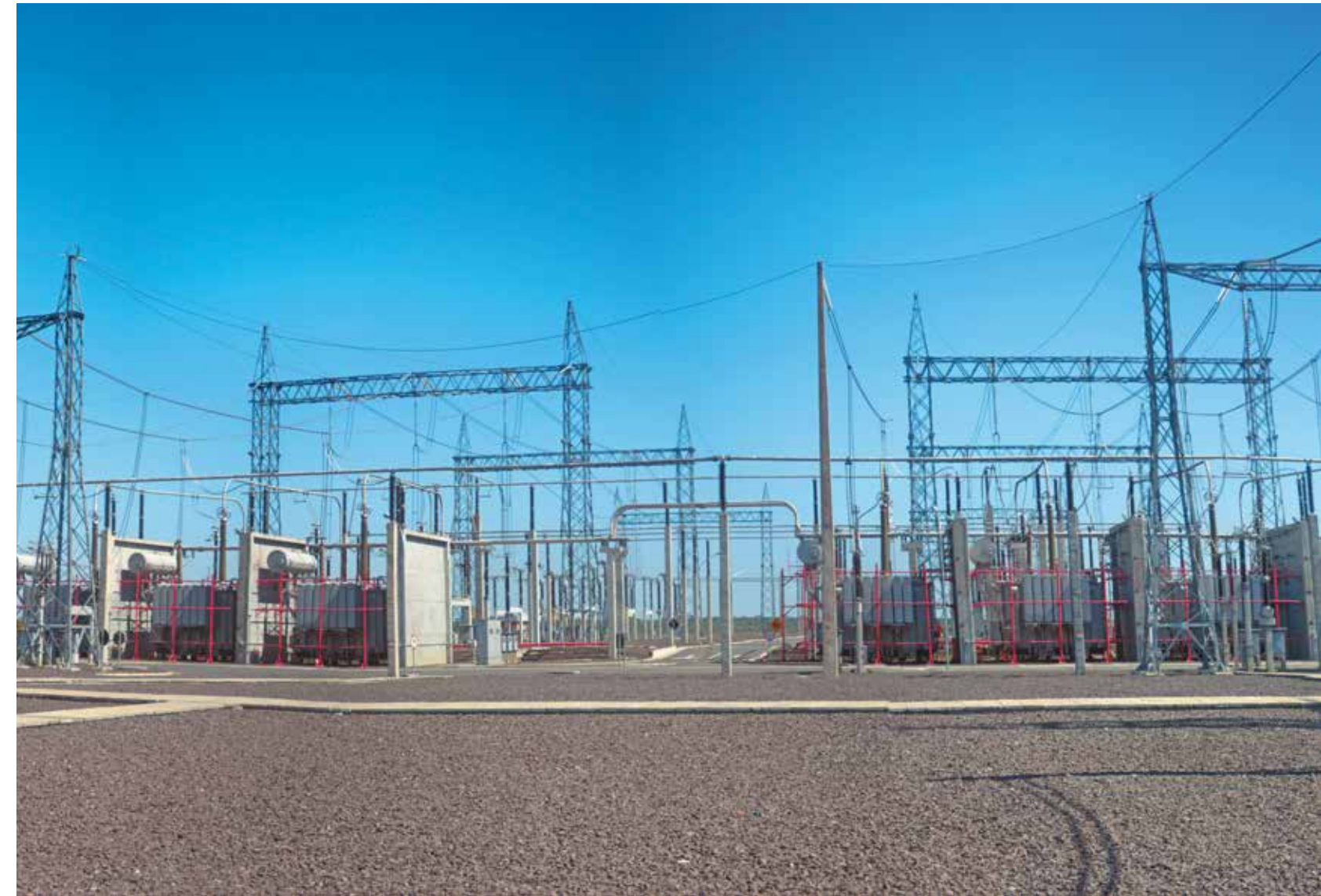
Patio de 500 kV – Estación Villa Hayes
