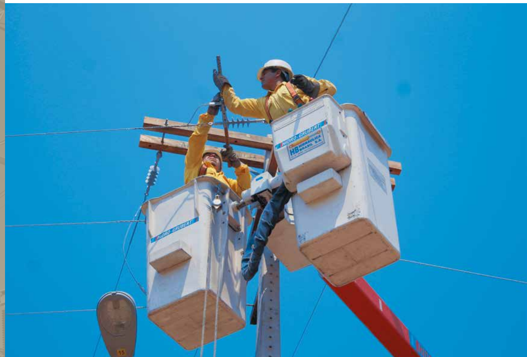
Mantenimiento de Líneas de Distribución
