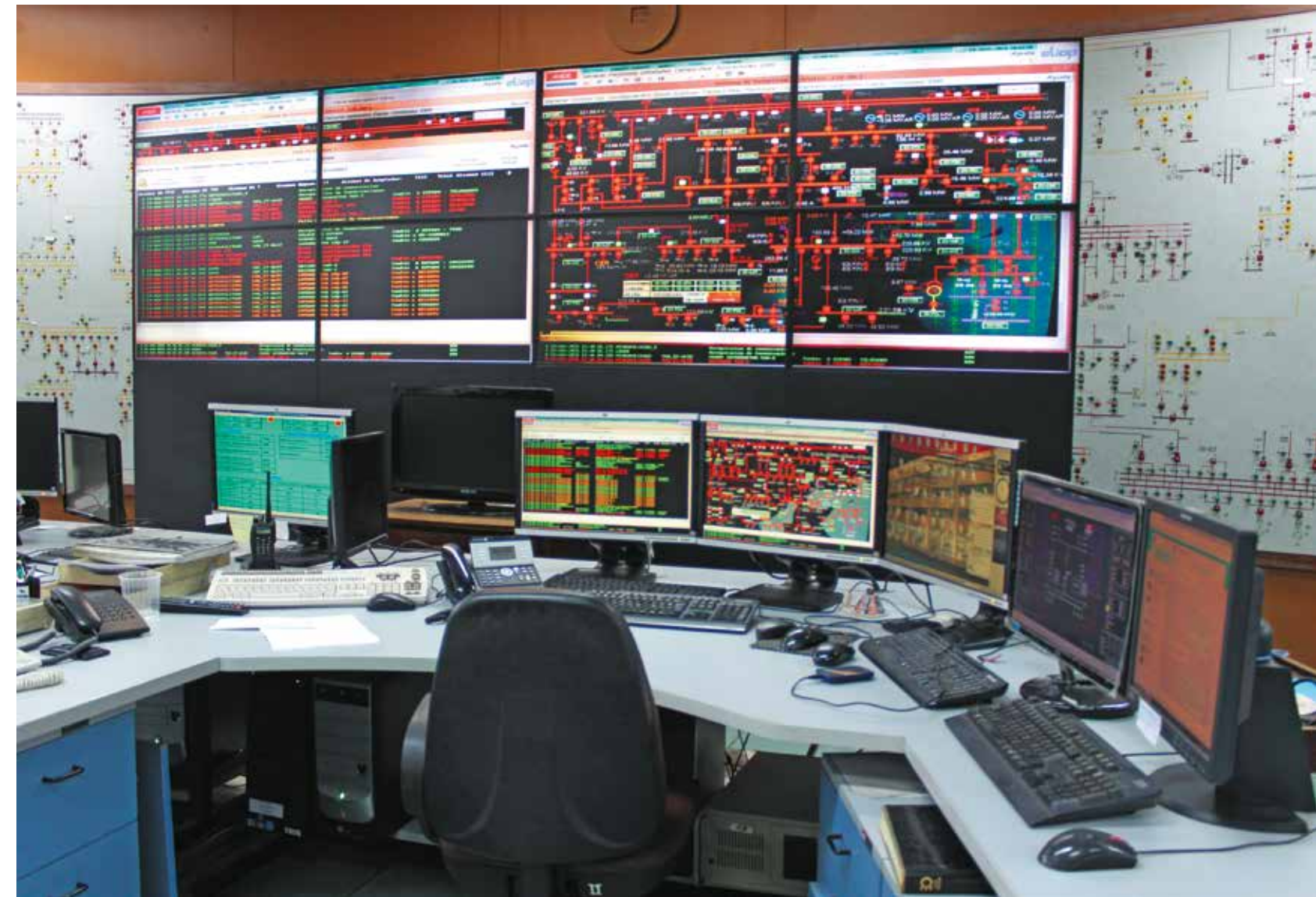
Sala de la Oficina del Despacho de Carga
