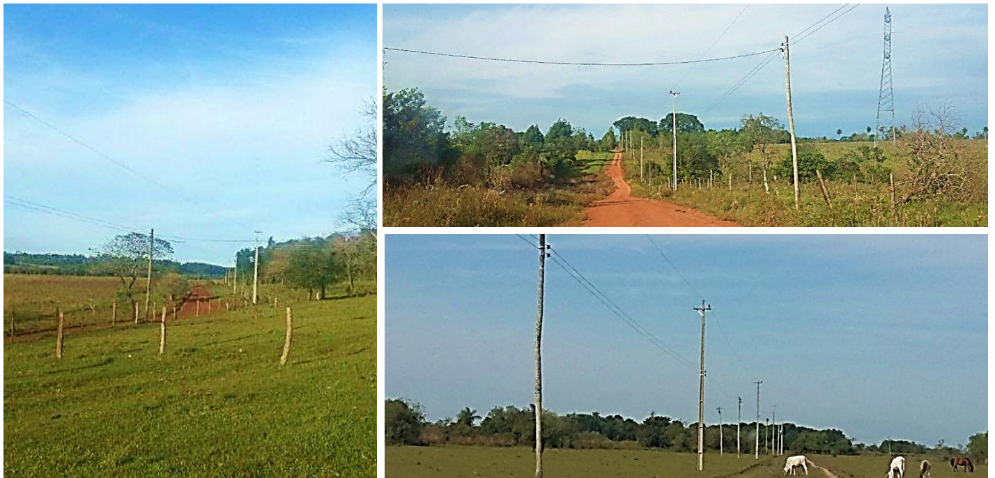
Ejecución de Trabajos de Normalización de Líneas de Autoayuda de BT y MT Licitación Pública Nacional ANDE N° 991/2014 - Lotes 3 y 6 - BONOS I
