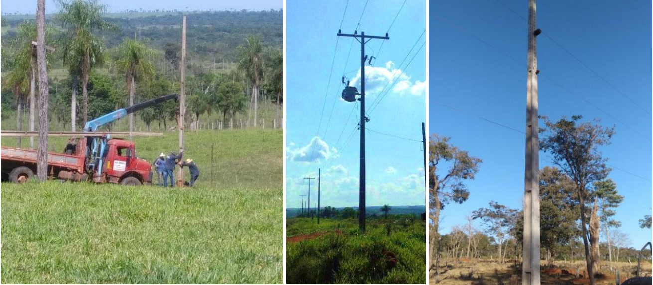
Ejecución de Trabajos de Normalización de Líneas de Autoayuda en MT y BT Canindeyú y San Pedro - Licitación Pública Nacional ANDE N° 1016/2014 - Lotes 1, 2, 3 - BONOS I
