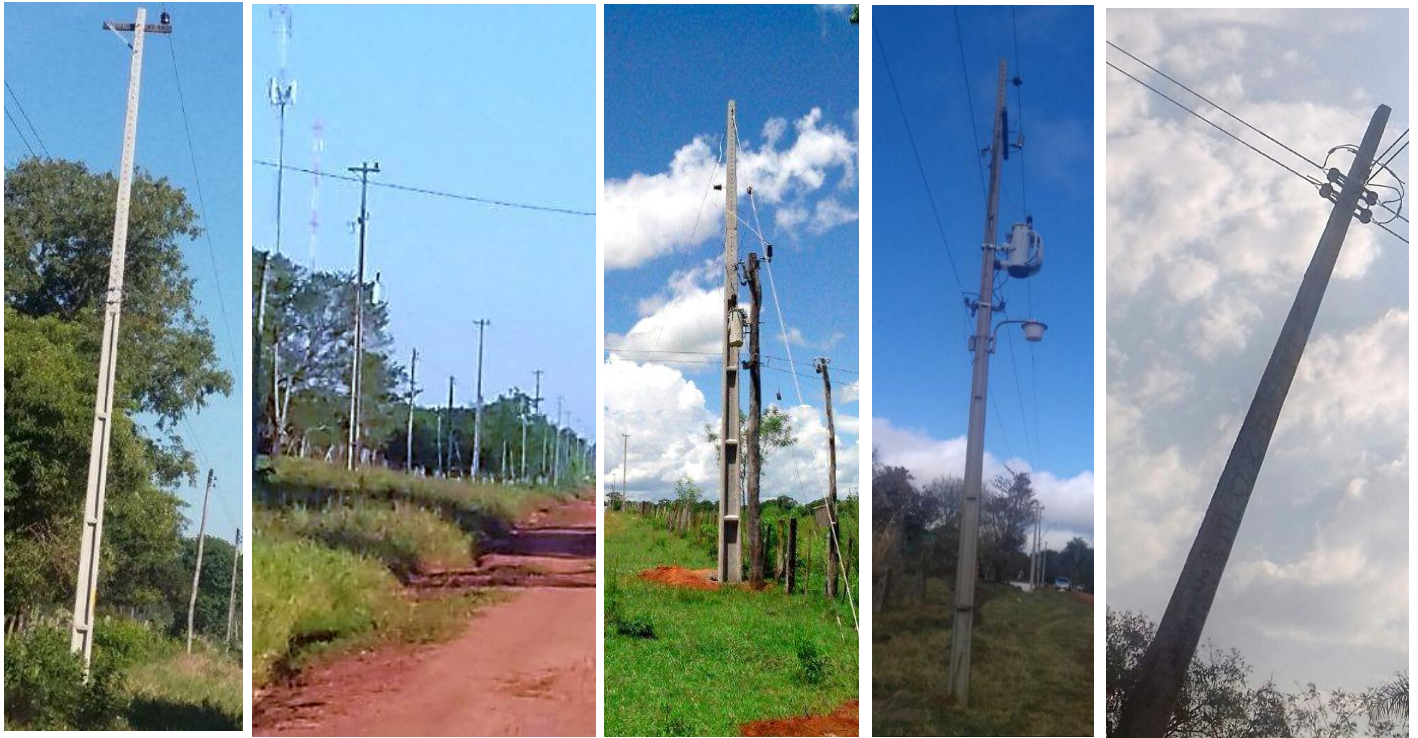
Ejecución de Trabajos de Normalización de Líneas de Autoayuda en MT y BT Licitación Pública Nacional ANDE N° 992/2014 – Lotes 1, 2, 3, 4 y 5 - BONOS I
