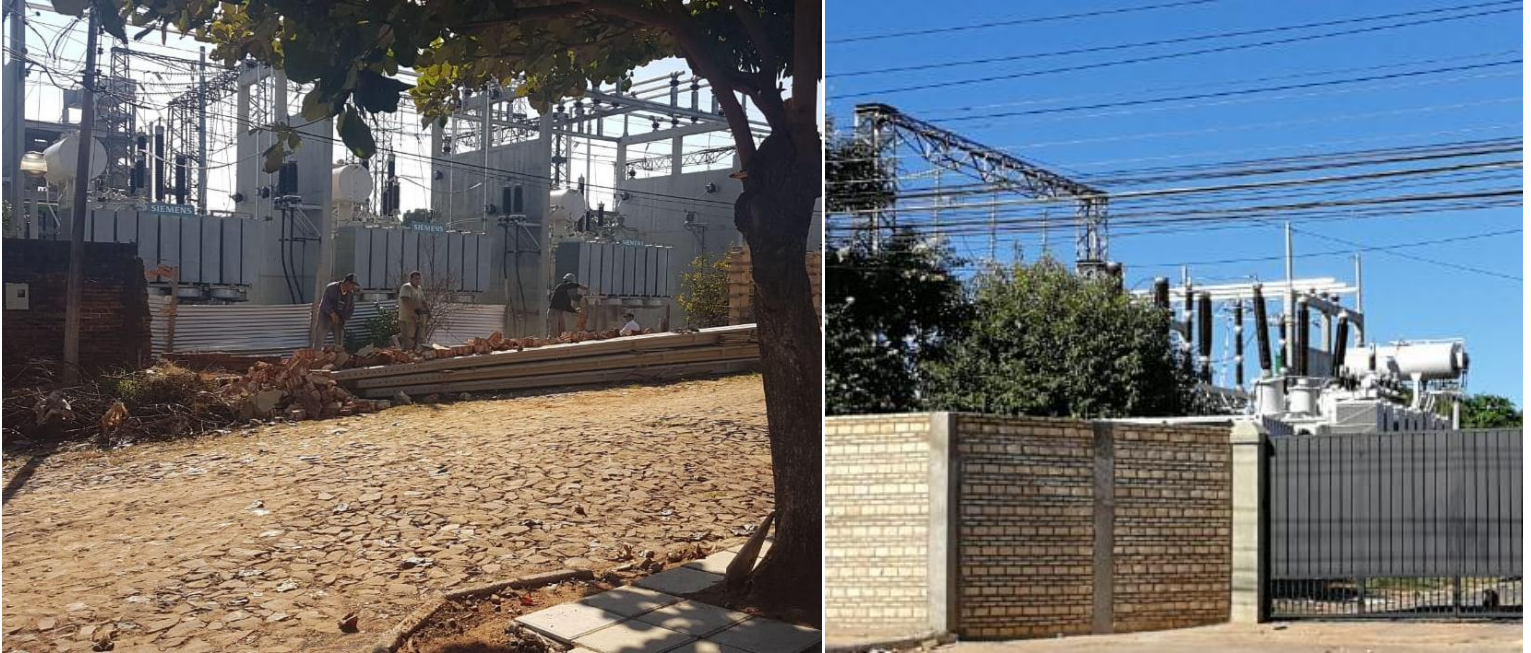
Ampliación de la Subestación LAMBARÉ Licitación Pública Internacional ANDE N° 914/2013 - Lote 5 - BONOS I
