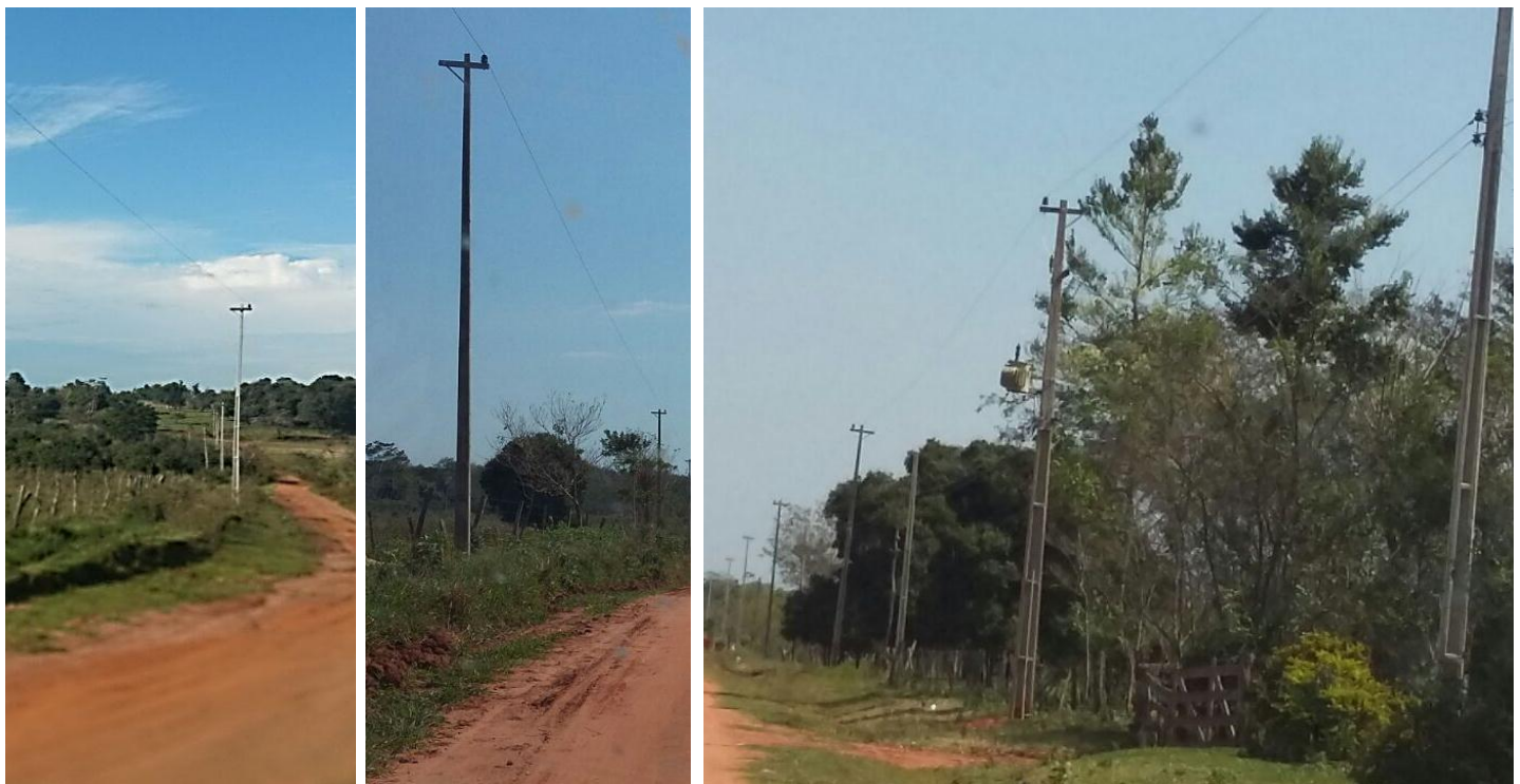
Ejecución de Trabajos de Normalización de Líneas de Autoayuda de BT y MT Licitación Pública Nacional ANDE N° 990/2014 - Lotes 1, 2 y 3 - BONOS I
