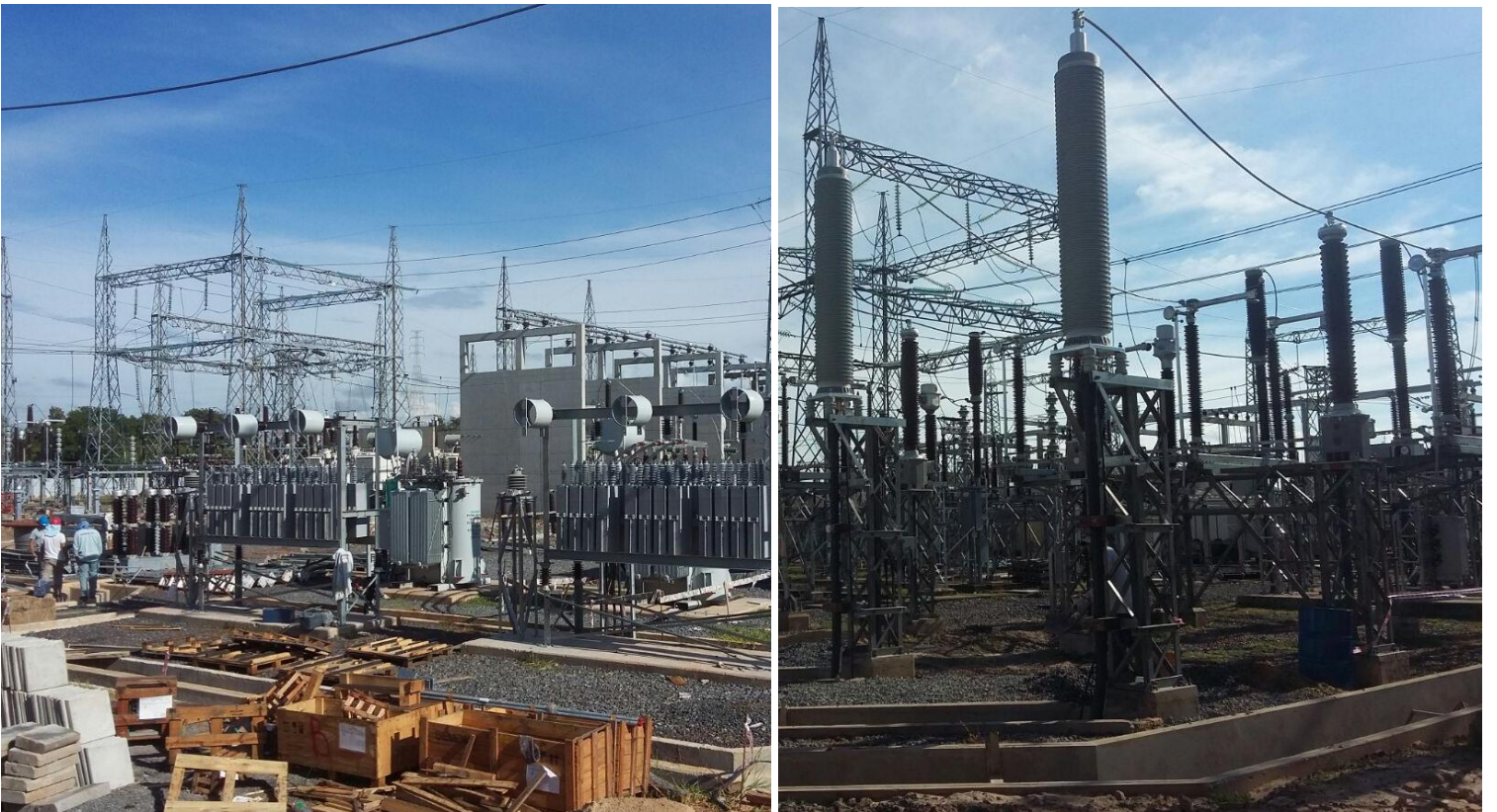
Ampliación de la Subestación PUERTO BOTÁNICO Licitación Pública Internacional ANDE N° 914/2013 - Lote 6 - BONOS I
