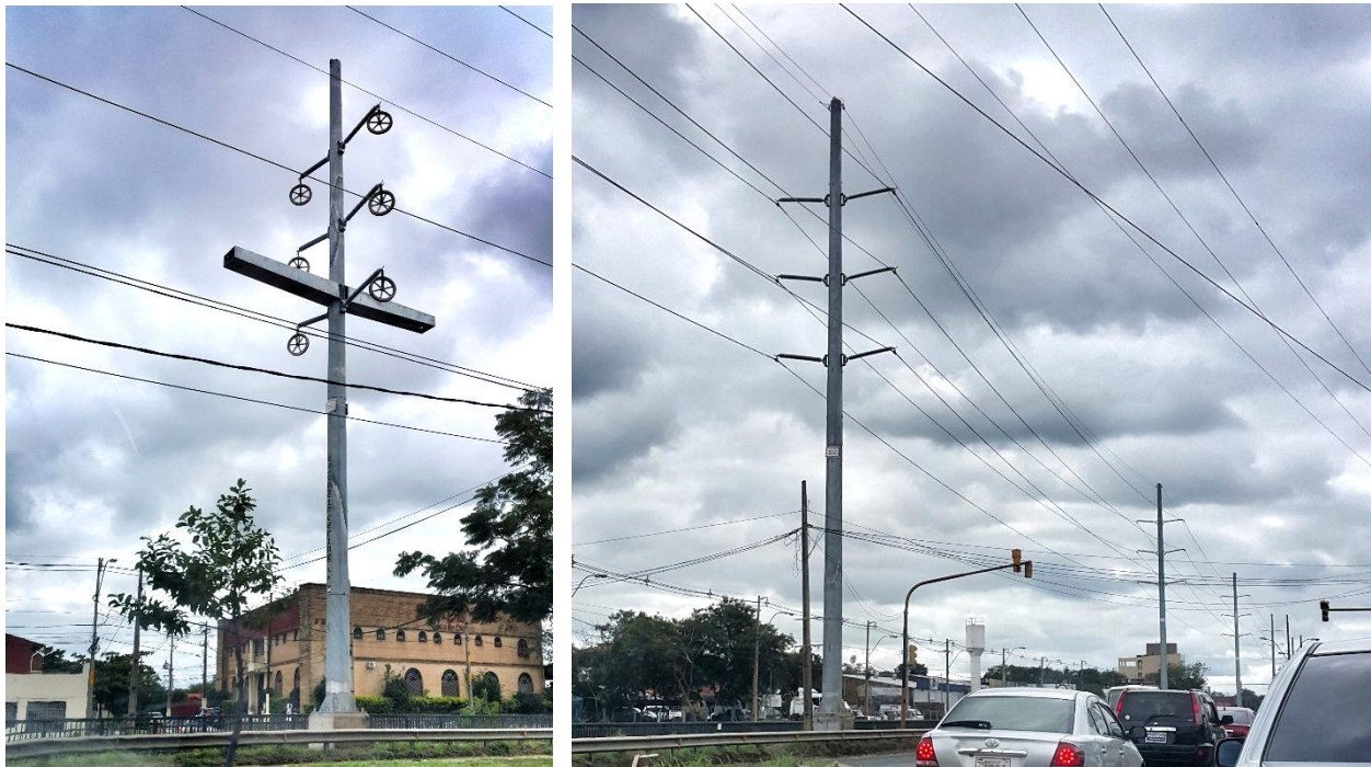
Construcción de la Línea de Transmisión de 220 kV entre las Subestaciones Puerto Botánico y Barrio Molino - Licitación Pública Nacional ANDE N° 1090/2014 - Lote 2 - BONOS II
