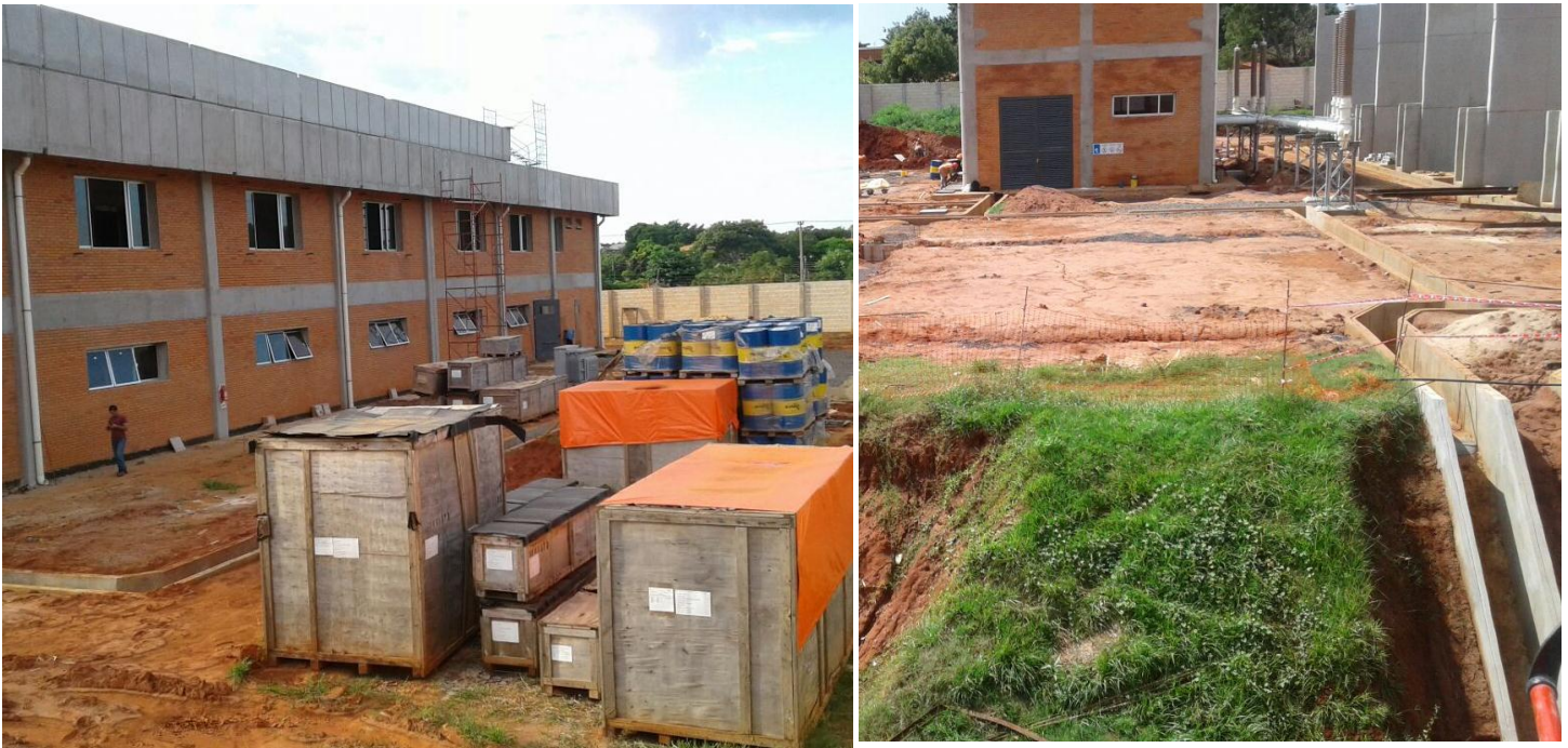
Construcción de la Subestación Barrio Molino en 220/66/23 - Licitación Pública Nacional ANDE N° 1090/2014 - Lote 1 - BONOS II
