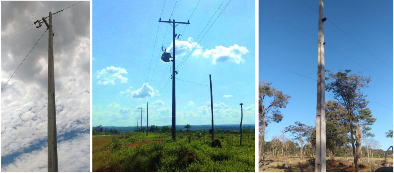
Ejecución de Trabajos de Normalización de Líneas de Autoayuda en MT y BT Canindeyú y San Pedro - Licitación Pública Nacional ANDE N° 1016/2014 - Lotes 1, 2, 3 - BONOS I
