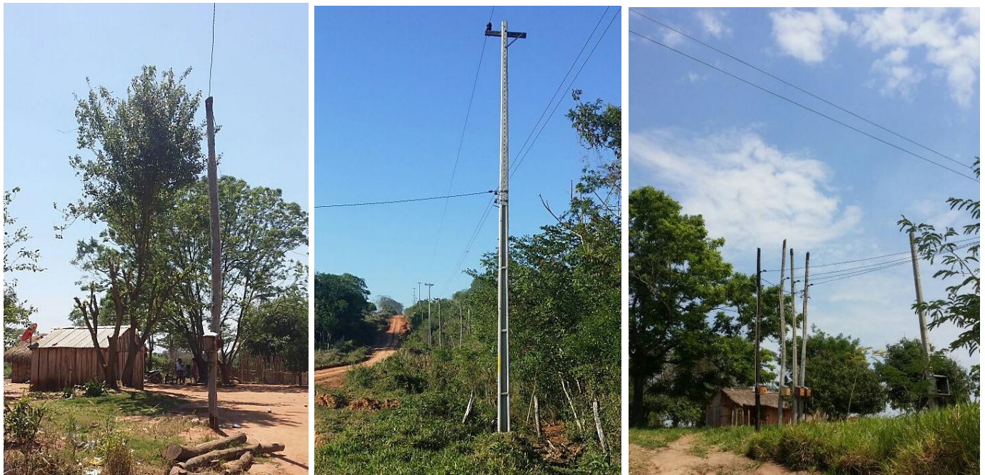
Ejecución de Trabajos de Normalización de Líneas de Autoayuda en MT y BT Canindeyú - Licitación Pública Nacional ANDE N° 1008/2014 – BONOS I
