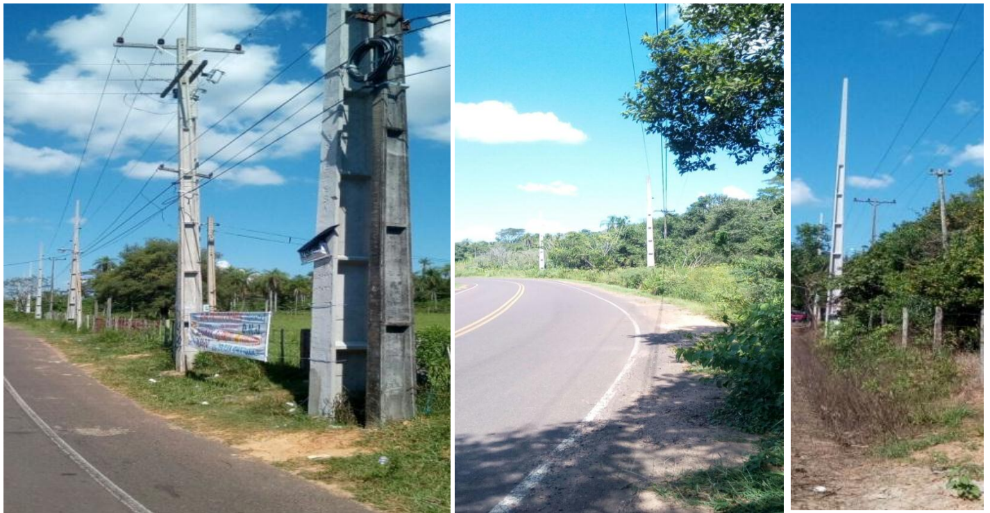
Construcción e interconexión de la Subestación Altos en 220 KV. Construcción de Obras de Distribución, incluyendo el suministro de materiales. Licitación Pública Nacional ANDE N° 1203/2016 - Lote 2 - BONOS II
