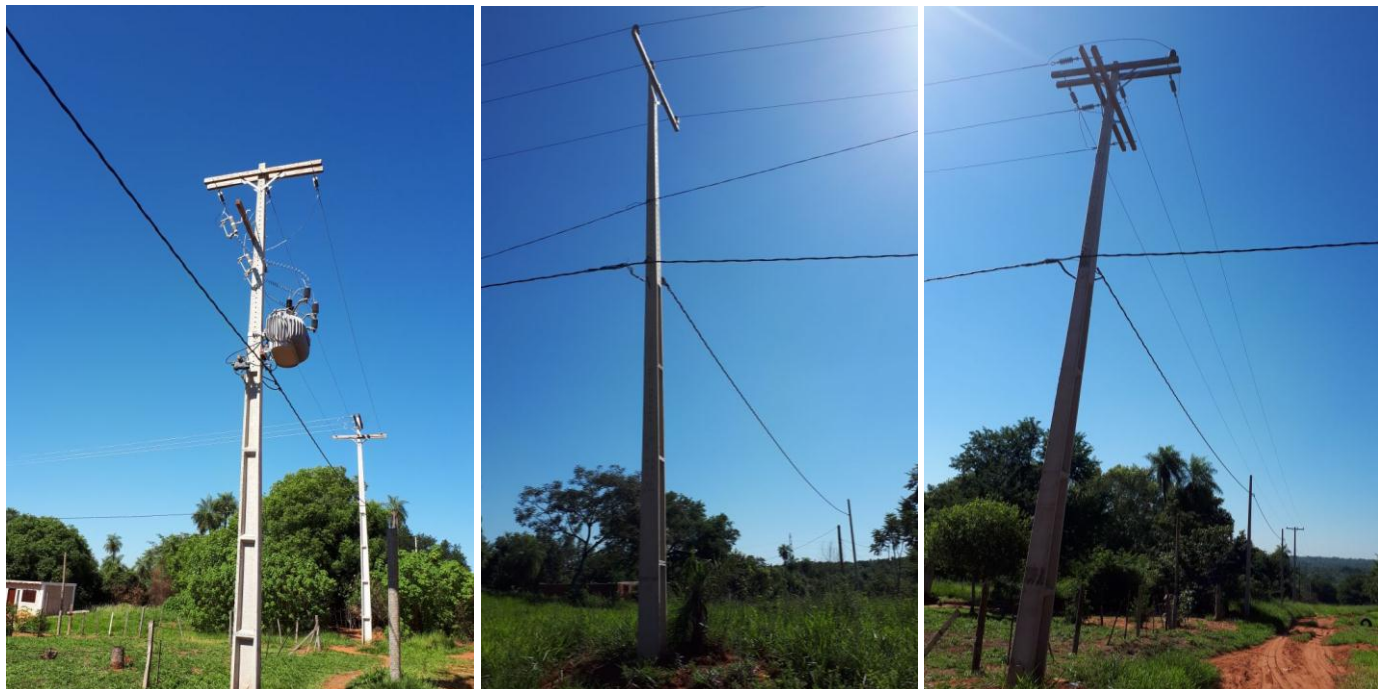
Construcción de Redes de MT, BT y Montaje de PD. Licitación Pública Nacional ANDE N° 1326/2017 - Lote 5 – BONOS II
