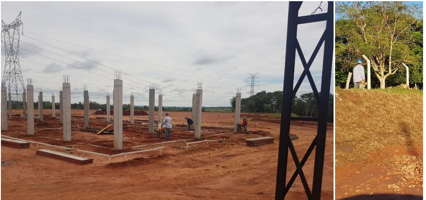
Construcción e Interconexión de la Subestación Altos en 220 kV, Licitación Pública Nacional ANDE N° 1203/2016 - Lote 1 - BONOS II
