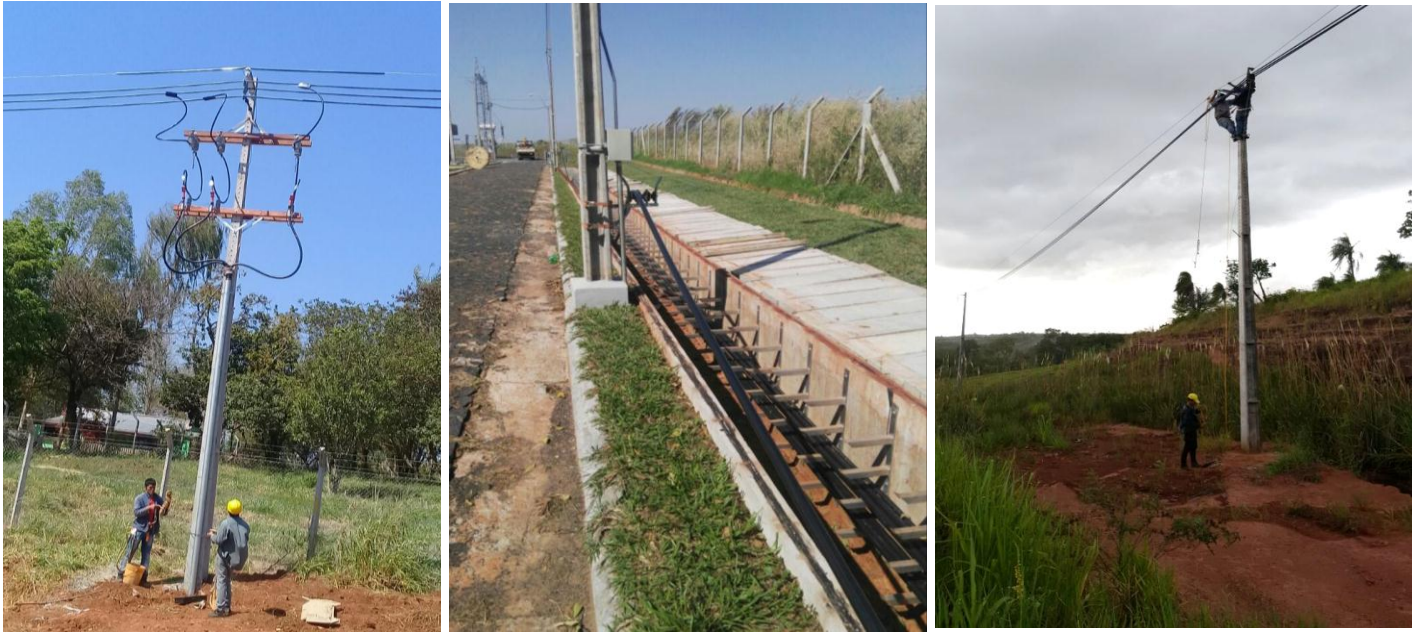
Construcción de Nuevos Alimentadores de Media Tensión emergentes del Centro de Distribución Curuguaty II, en el Distrito de Curuguaty, Departamento de Canindeyú- Licitación Pública Nacional ANDE N° 1221/2016 – BONOS I
