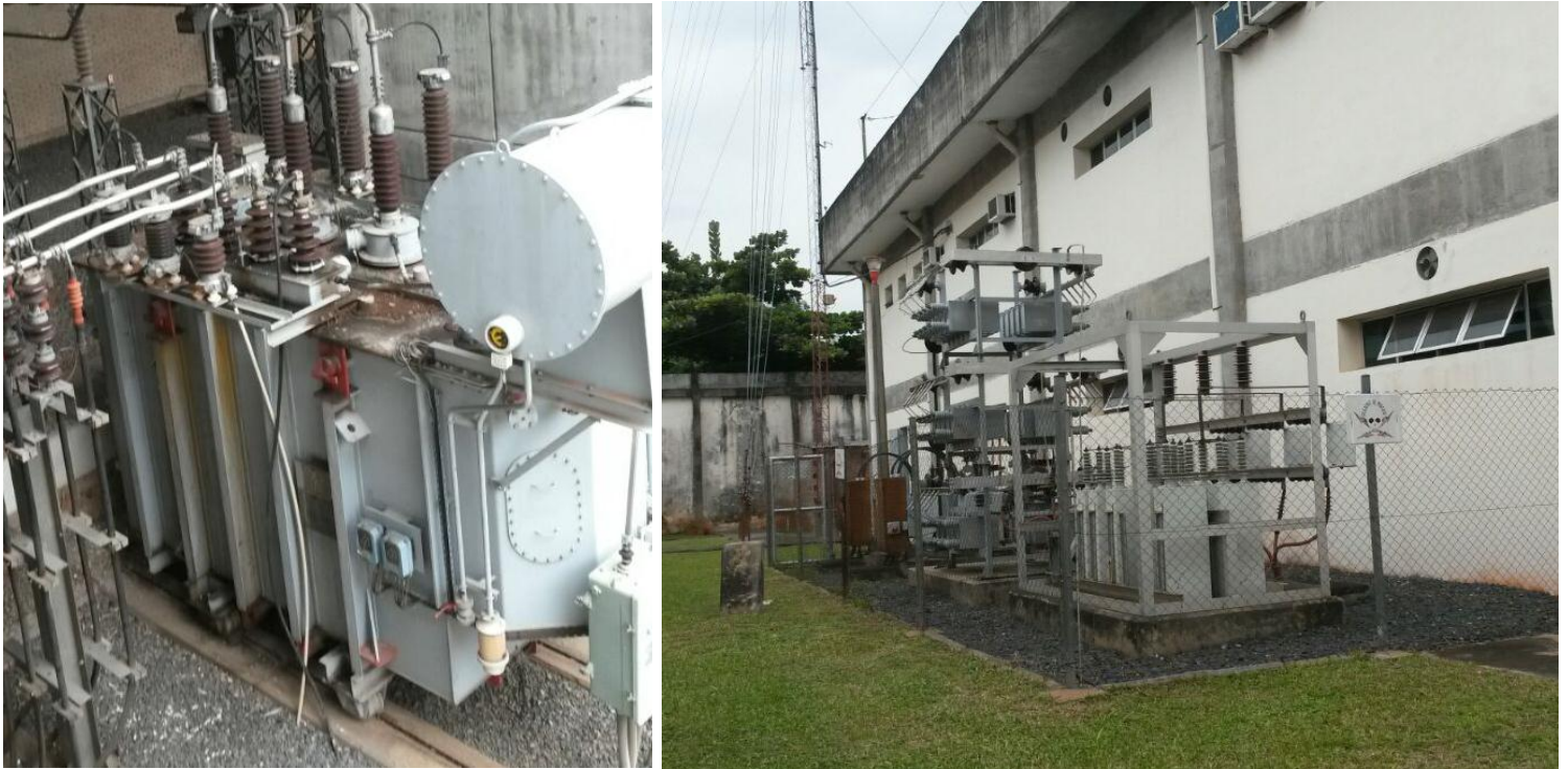
Ampliación de la Subestación GENERAL DIAZ Licitación Pública Internacional ANDE N° 914/2013 - Lote 7 - BONOS I
