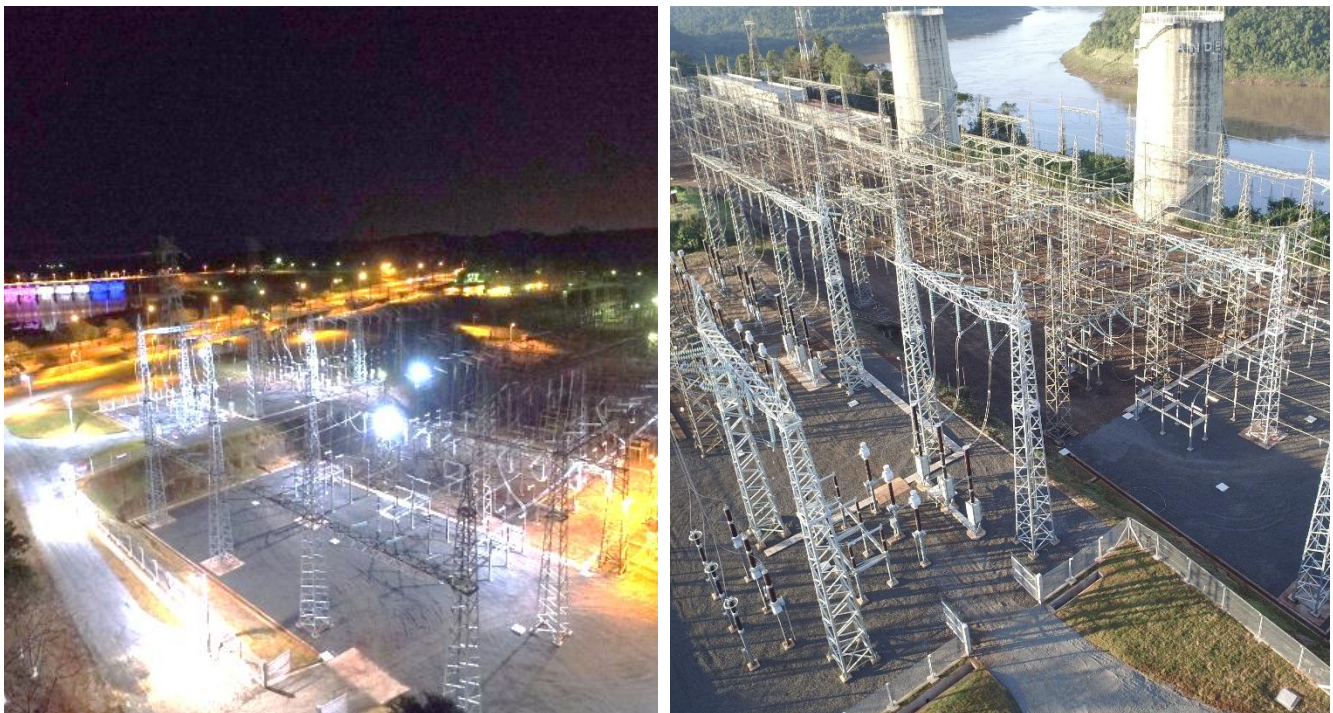
Ampliación de la Subestación Acaray y Pte. Franco Licitación Pública Nacional ANDE N° 1088/2014 - Lote 1 - BONOS II
