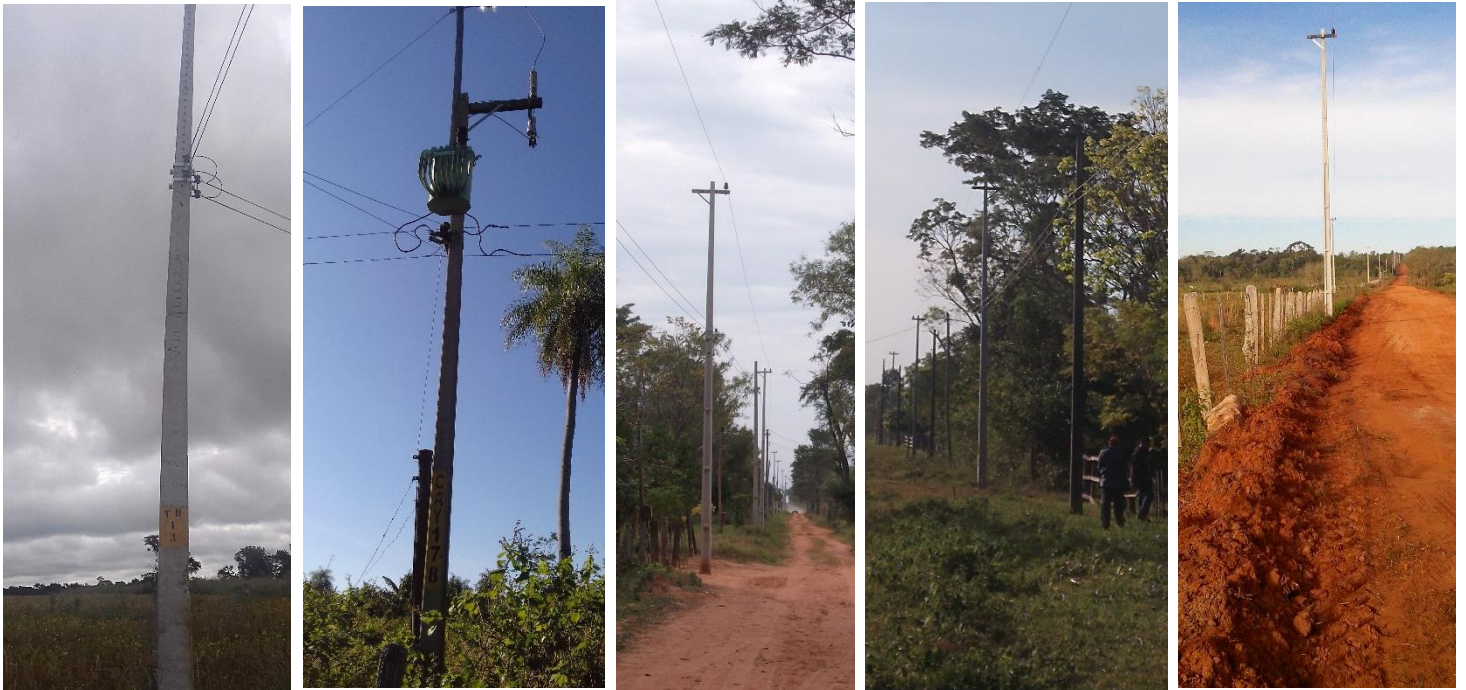
Ejecución de Trabajos de Normalización de Líneas de Autoayuda de BT y MT Licitación Pública Nacional ANDE N° 990/2014 - Lotes 4, 5, 6, 7 y 8 - BONOS I
