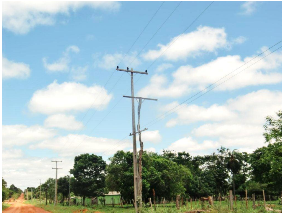
Ejecución de Trabajos de Normalización de Líneas de Autoayuda en MT y BT Canindeyú, Maracaná - Licitación Pública Nacional ANDE N° 969/2014 - BONOS I
