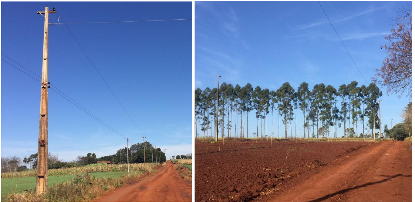
Ejecución de trabajos de normalización de líneas de autoayuda en MT y BT, en el Dpto. de Itapúa, Distrito de Tomas Romero Pereira - Licitación Pública Nacional ANDE N° 1196/2016 - BONOS I
