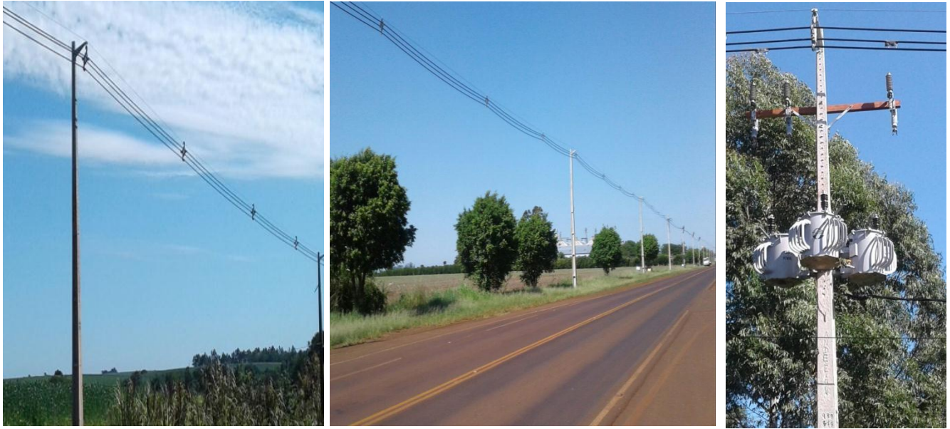
Construcción de Obras de Distribución con provisión total de materiales, Distrito de Fram, Dpto. de Itapúa - Licitación Pública Nacional ANDE N° 1200/2016 - Lote 3 - BONOS II
