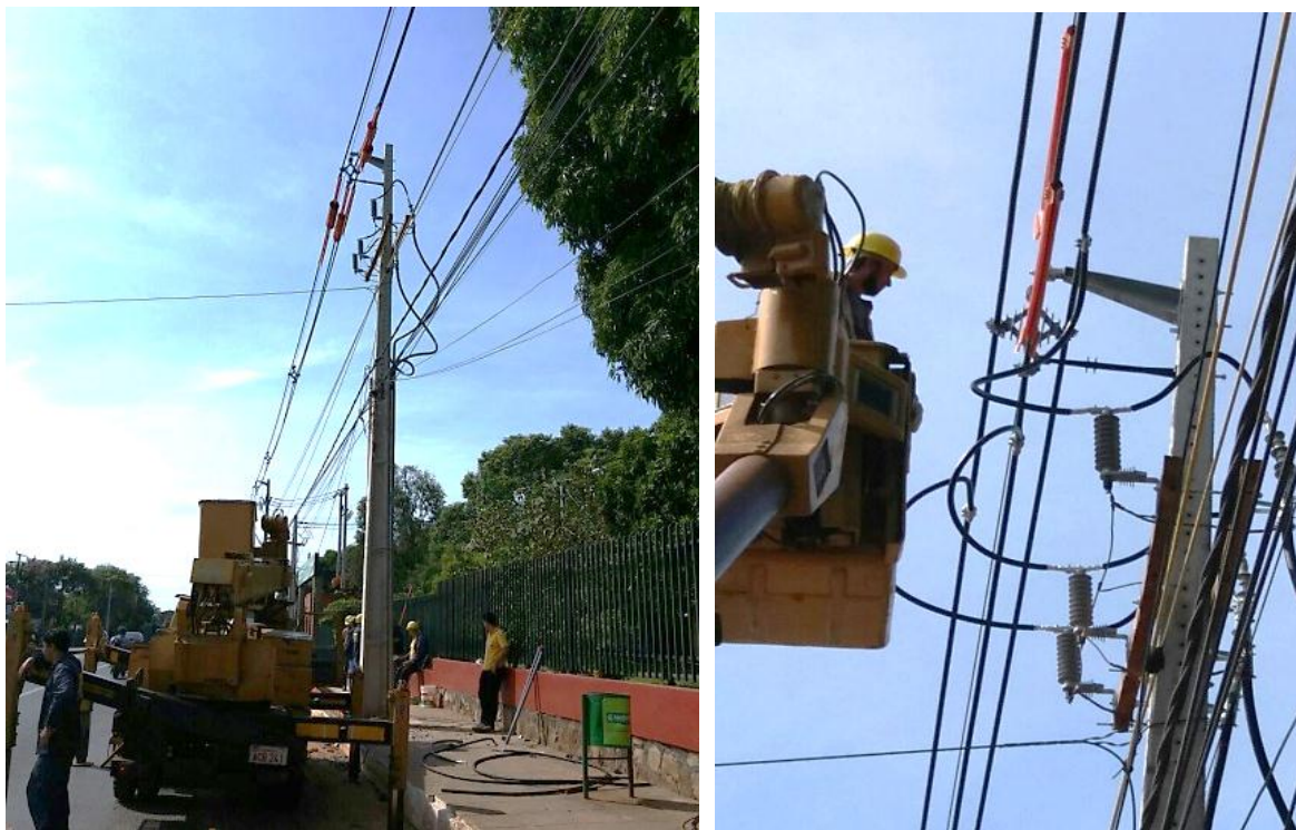
Construcción de Nuevos Alimentadores de Media Tensión emergentes del Futuro Centro de Distribución Fernando de la Mora, Distritos de Fdo. de la Mora y Asunción- Licitación Pública Nacional ANDE N° 1222/2016 - BONOS I
