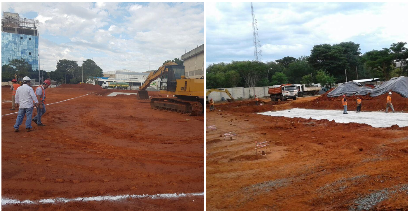
Construcción e Interconexión de la Subestación Villa Aurelia en 220 kV - Licitación Pública Nacional ANDE N° 1089/2014 - Lote 1 - BONOS II
