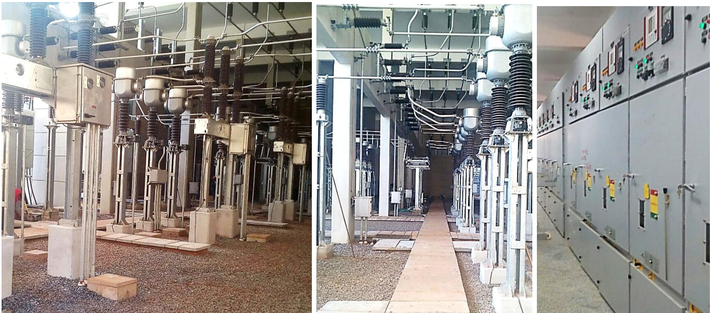
Construcción de la Subestación FERNANDO DE LA MORA y Ampliación de la Subestación SAN LORENZO - Licitación Pública Nacional ANDE N° 852/2013 - Lote 1 - BONOS I
