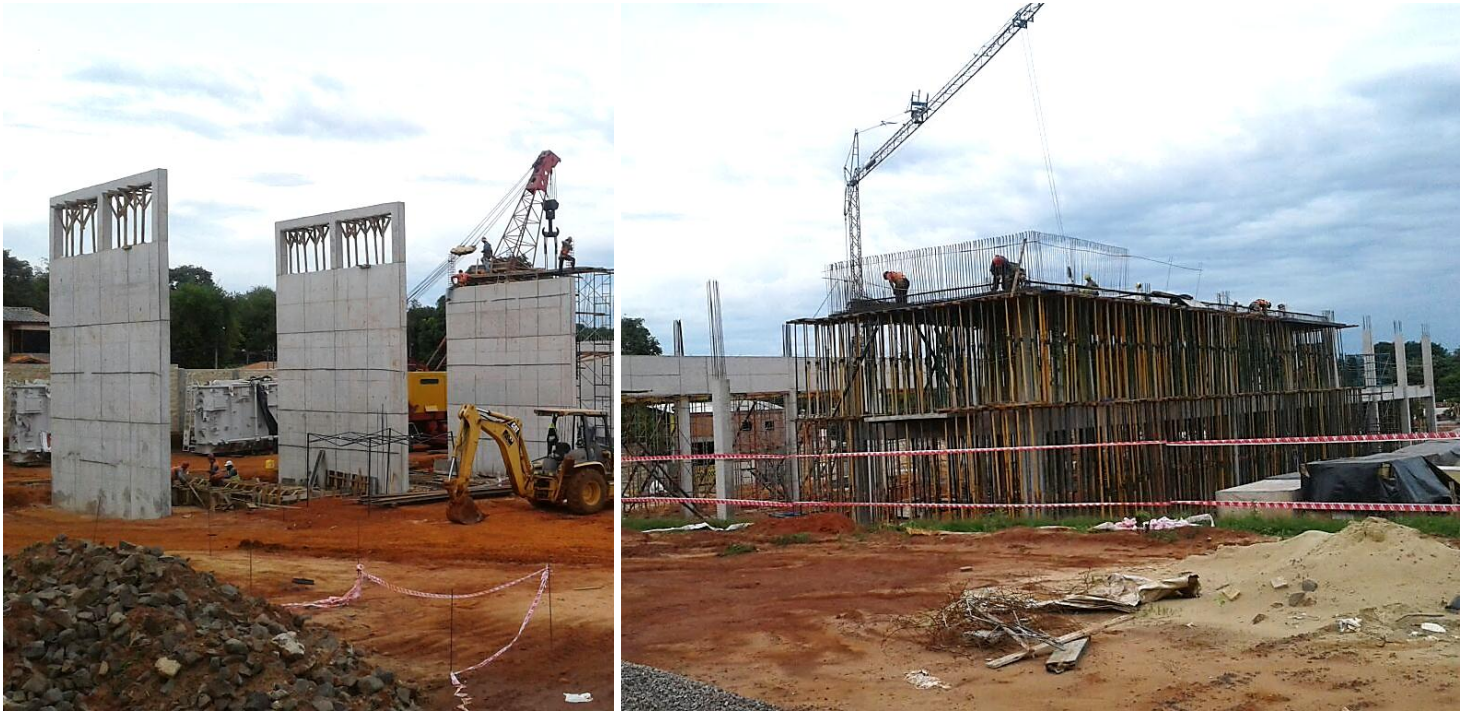
Construcción de la Subestación Barrio Molino en 220/66/23 - Licitación Pública Nacional ANDE N° 1090/2014 - Lote 1 - BONOS II
