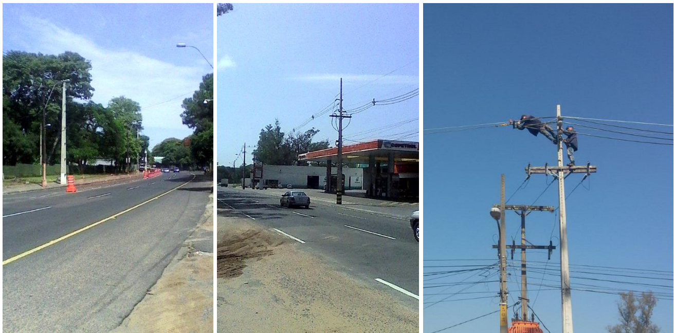
Adecuación de red de MT y BT a Protegida y Preensamblada en los Alimentadores de los Centros de Distribución San Lorenzo, La Victoria y Capiatá, en Distritos de San Lorenzo, Capiatá y Areguá, en el Dpto. Central- Licitación Pública Nacional ANDE N° 1036/2014 - Lotes 1 y 4 - BONOS I
