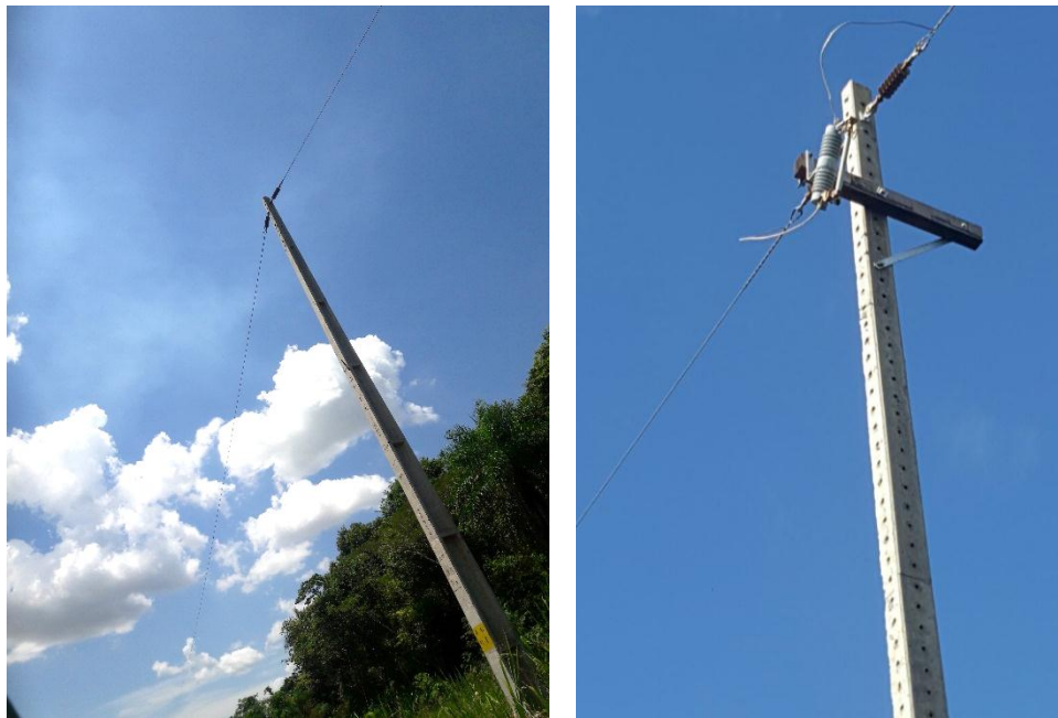
Ejecución de trabajos de normalización de líneas de autoayuda en MT y BT, en el Dpto. de Itapúa, Distrito de Tomas Romero Pereira - Licitación Pública Nacional ANDE N° 1196/2016 - BONOS I
