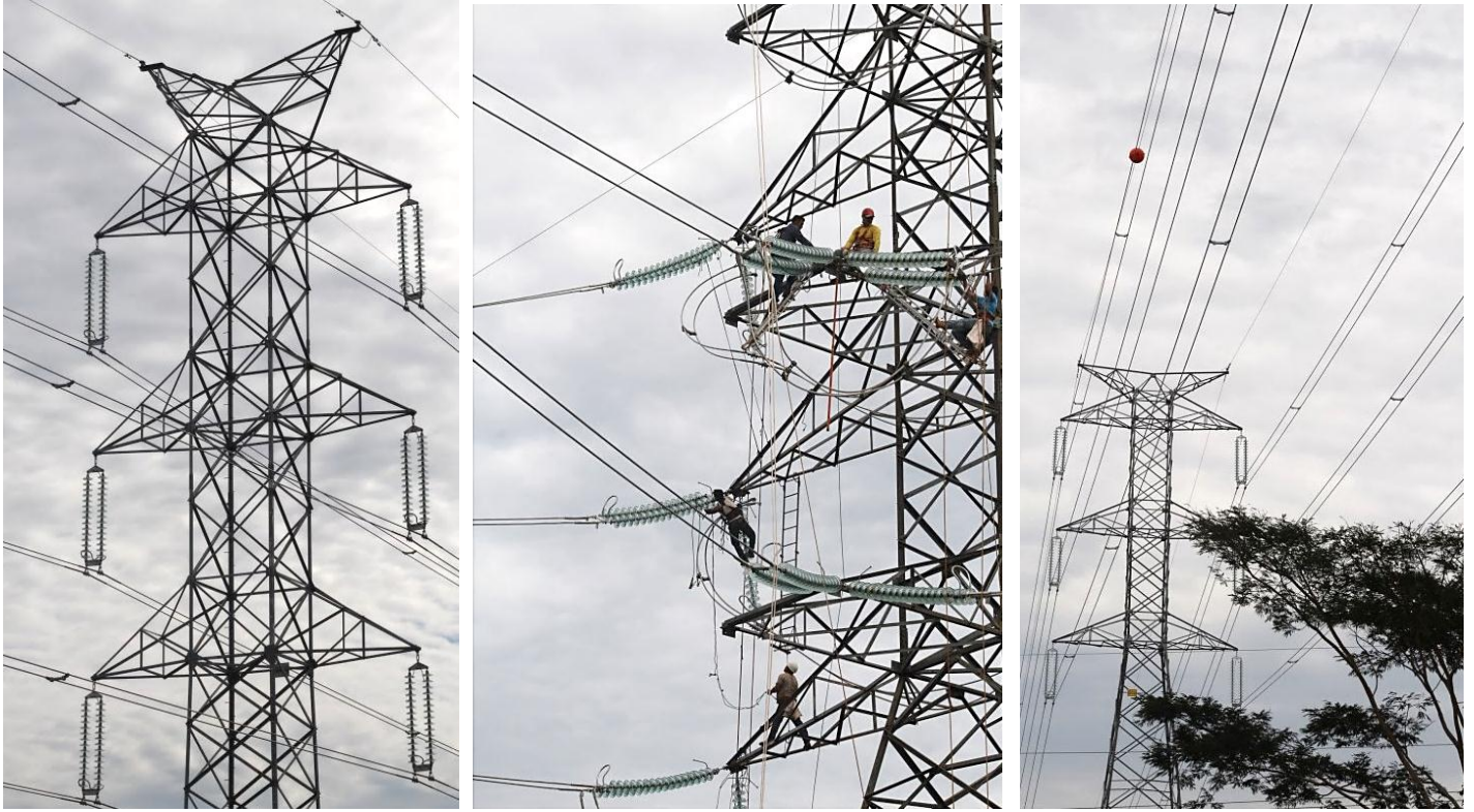
Construcción de la línea de transmisión 2 x 220 kV Acaray - Pte. Franco - Licitación Pública Nacional ANDE N° 1088/2014 - Lote 2 - BONOS II
