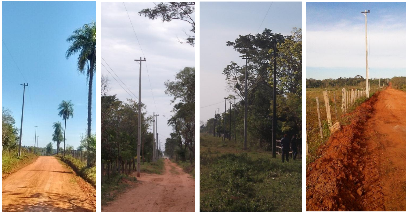
Ejecución de Trabajos de Normalización de Líneas de Autoayuda de BT y MT Licitación Pública Nacional ANDE N° 990/2014 - Lotes 5, 6, 7 y 8 - BONOS I
