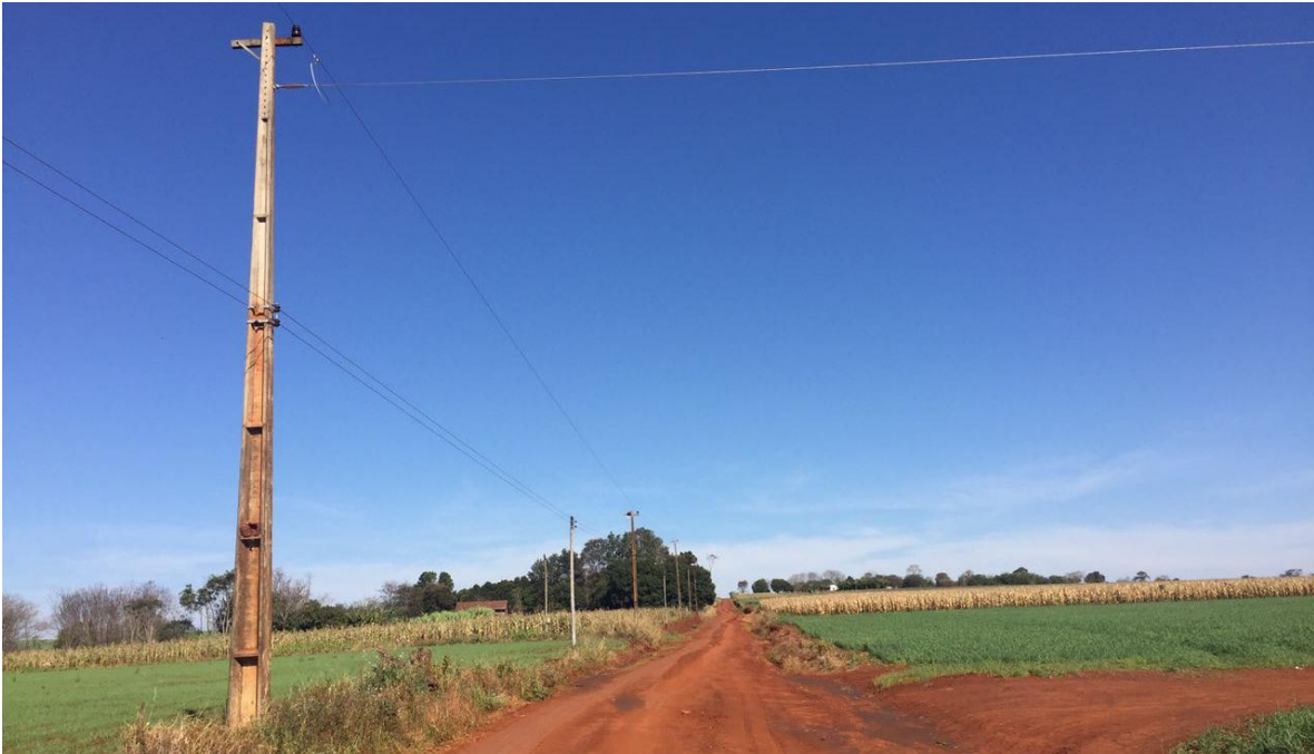
Ejecución de trabajos de normalización de líneas de autoayuda en MT y BT, en el Dpto. de Itapúa, Distrito de Tomas Romero Pereira - Licitación Pública Nacional ANDE N° 1196/2016 - BONOS I
