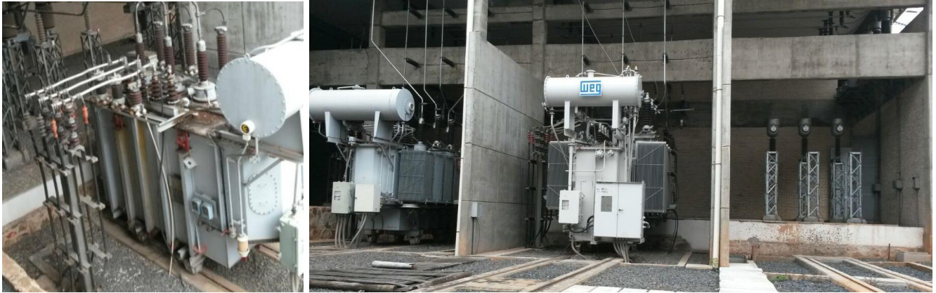
Ampliación de la Subestación GENERAL DIAZ Licitación Pública Internacional ANDE N° 914/2013 - Lote 7 - BONOS I
