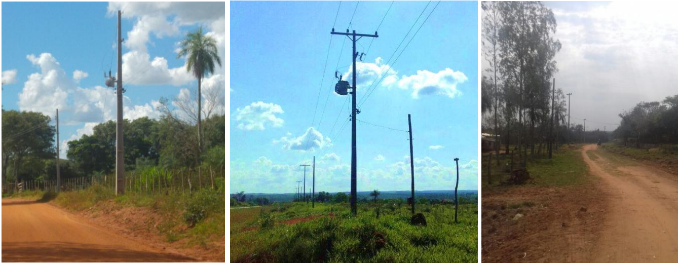
Ejecución de Trabajos de Normalización de Líneas de Autoayuda en MT y BT Canindeyú y San Pedro - Licitación Pública Nacional ANDE N° 1016/2014 - Lotes 1, 2, 3 - BONOS I
