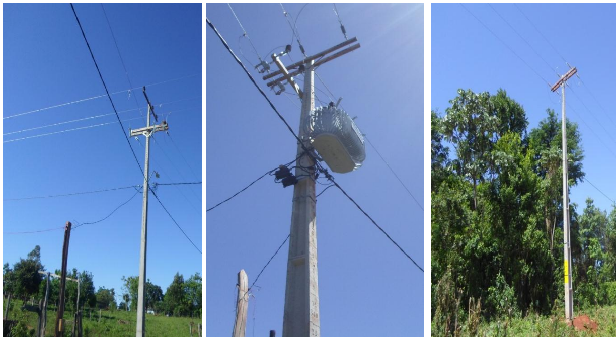
Ampliación de Línea de MT y BT, Montaje de Puesto de Distribución para el Asentamiento Ñu Pyahu, Distrito de Tavaí, Dpto. de Caazapá - Licitación Pública Nacional ANDE N° 1194/2016 - BONOS I
