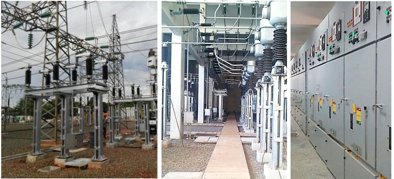
Construcción de la Subestación FERNANDO DE LA MORA y Ampliación de la Subestación SAN LORENZO - Licitación Pública Nacional ANDE N° 852/2013 - Lote 1 - BONOS I
