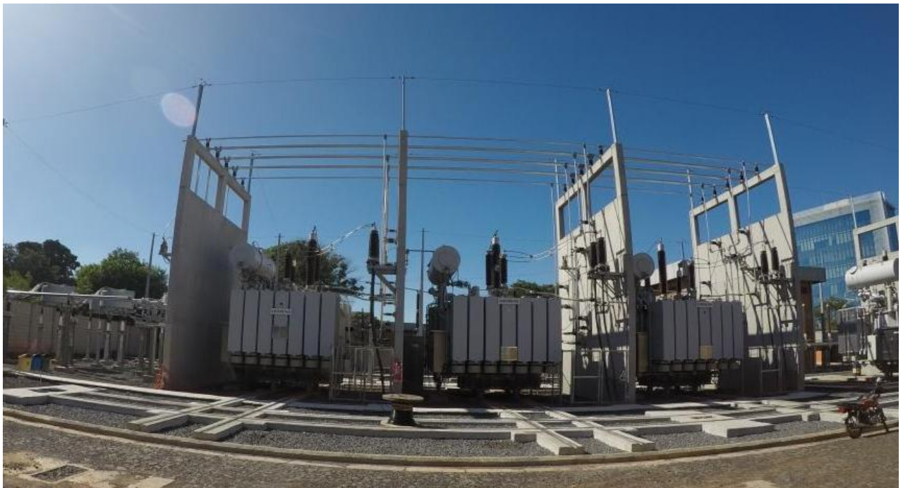
Construcción e Interconexión de la Subestación Villa Aurelia en 220 kV - Licitación Pública Nacional ANDE N° 1089/2014 - Lote 1 - BONOS II
