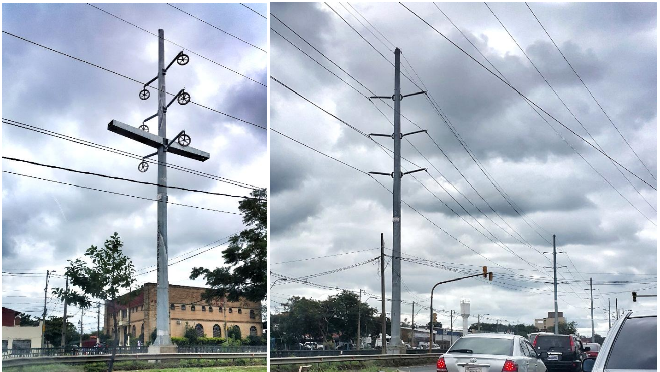
Construcción de la Línea de Transmisión de 220 kV entre las Subestaciones Puerto Botánico y Barrio Molino - Licitación Pública Nacional ANDE N° 1090/2014 - Lote 2 - BONOS II
