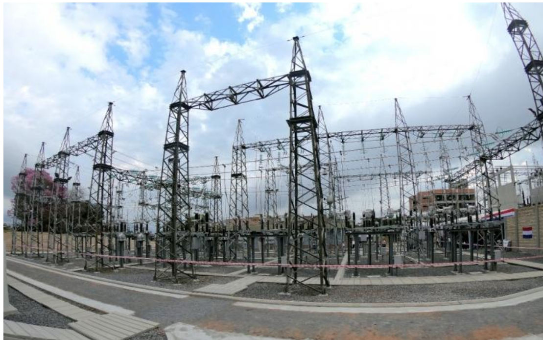
Ampliación de la Subestación LAMBARÉ Licitación Pública Internacional ANDE N° 914/2013 - Lote 5 - BONOS I
