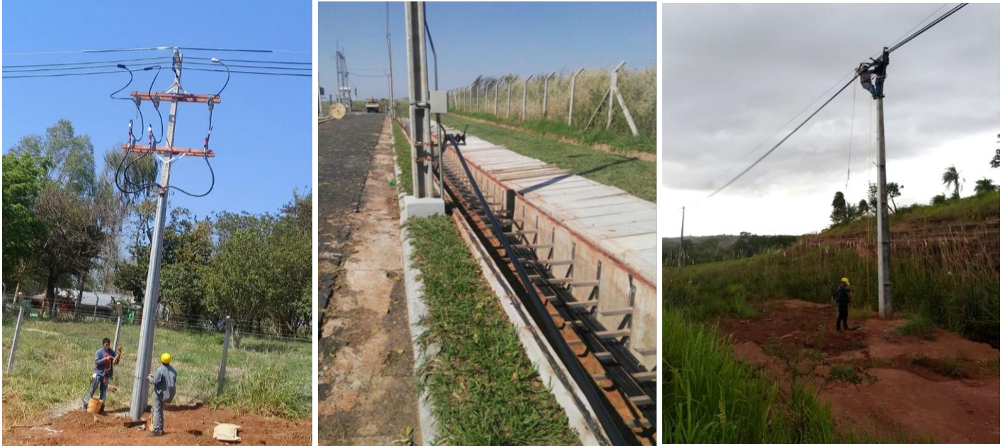
Construcción de Nuevos Alimentadores de Media Tensión emergentes del Centro de Distribución Curuguay II, en el Distrito de Curuguay, Departamento de Canindeyú- Licitación Pública Nacional ANDE N° 1221/2016 – BONOS I
