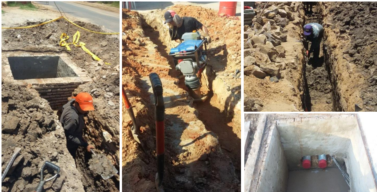
Construcción de Nuevas Líneas de MT PBO 02-05, para alimentación de viviendas sociales en el RC4, en las Ciudades de Asunción y Mariano Roque Alonso, Distrito Capital y Dpto. Central - Licitación Pública Nacional ANDE N° 1168/2015 – Bonos II
