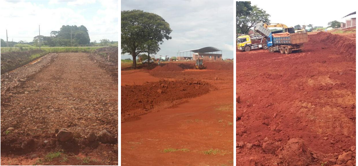
Construcción e Interconexión de la Subestación Fram 66 kV - Licitación Pública Nacional ANDE N° 1200/2016 - Lote 1 - BONOS II
