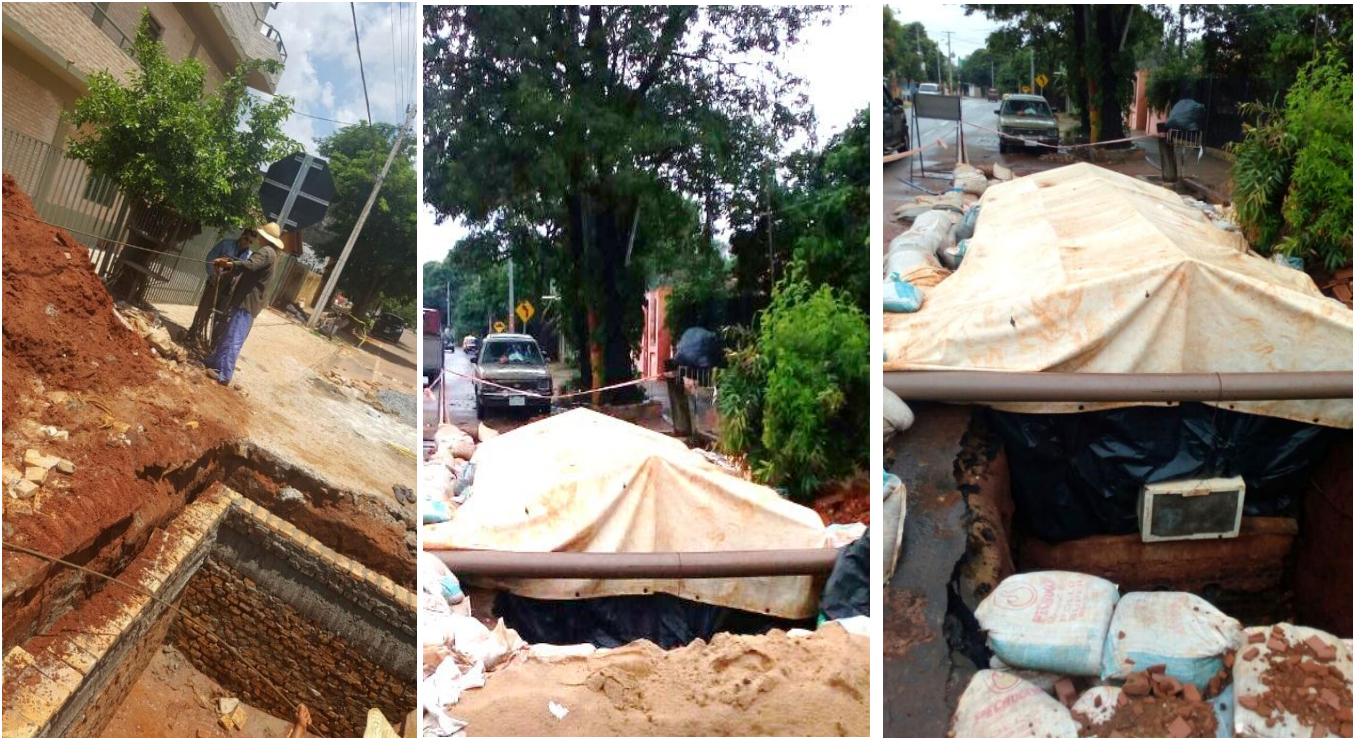
Construcción de LT Subterránea 66 kV - Refuerzo del Sistema Metropolitano - San Lorenzo - Fernando de la Mora, Licitación Pública Nacional ANDE N° 1230/2016 - Lote 1 - BONOS I
