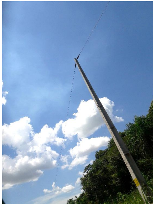
Ejecución de trabajos de normalización de líneas de autoayuda en MT y BT, en el Dpto. de Itapúa, Distrito de Tomas Romero Pereira - Licitación Pública Nacional ANDE N° 1196/2016 - BONOS I
