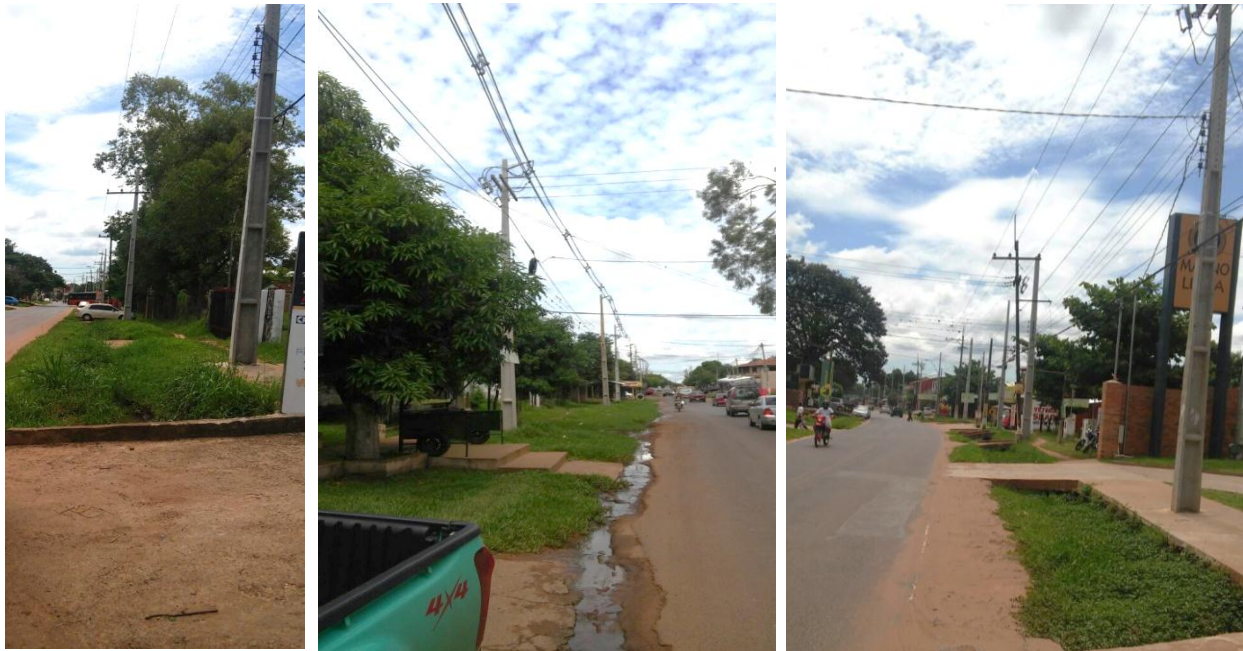
Adecuación de Red de MT y BT a Protegida y Preensamblada en Distritos de Asunción y del Dpto. Central- Licitación Pública Nacional ANDE N° 1094/2015 – Lotes 1 y 4 - BONOS I
