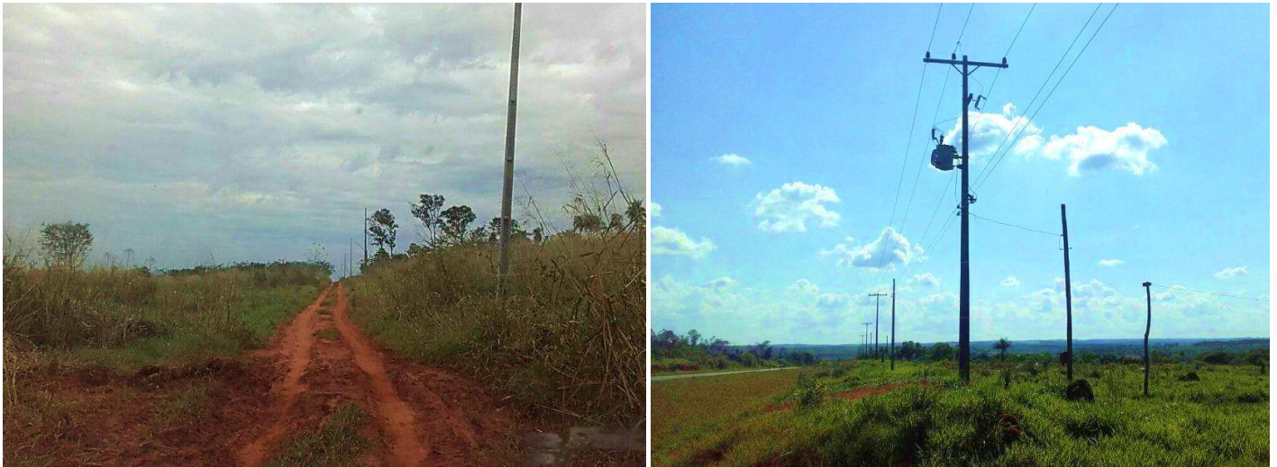
Ejecución de Trabajos de Normalización de Líneas de Autoayuda en MT y BT Canindeyú y San Pedro - Licitación Pública Nacional ANDE N° 1016/2014 - Lote 2 - BONOS I
