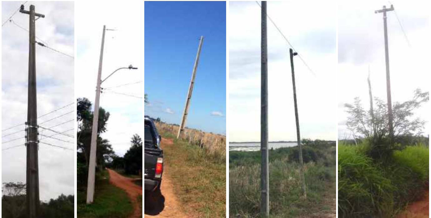
Ejecución de trabajos de normalización de líneas de autoayuda en MT y BT, en los Dptos. de Guairá, Misiones y Paraguairí – Licitación Pública Nacional ANDE N° 1169/2015 - Lotes 1, 2, 3, 4 v 5 - BONOS II
