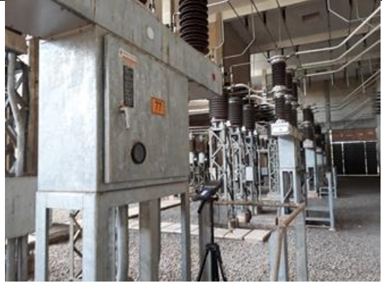
Subestación Republicano – Patio de maniobras – Zona de Interruptor
