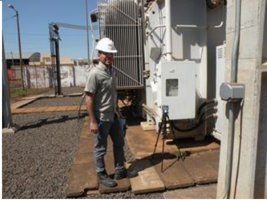
Subestación Pedro Juan Caballero – Patio de maniobras – Transformador de potencia
