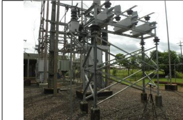
Subestación San Pedro del Paraná – Patio de maniobras - Zona de capacitores
