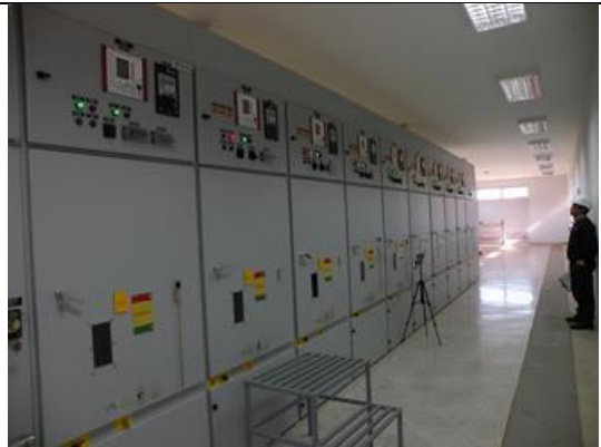
Subestación Jopopyhy – Casa de Control - Sala de 23kV
