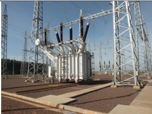
Subestación Katuete – Zona de Transformador de potencia
