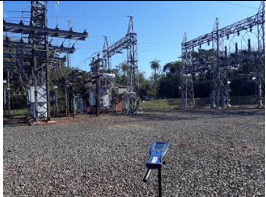
Subestación Paraguari – Patio de maniobras
