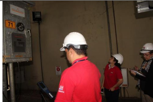
Foto 4. Medición de CEM – Patio de maniobras, Subestación Central
